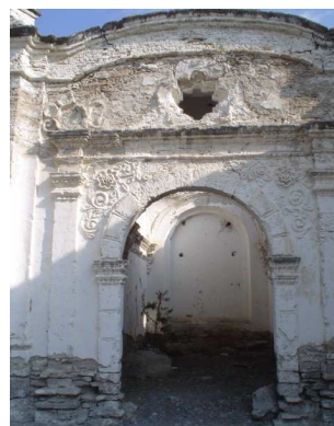
Vista de la fachada principal
