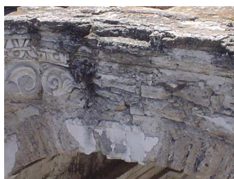
Techumbre de perfil de bóveda hecha de piedra caliza con juntas de onix
