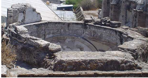
Foto de la desplantación de la cúpula vista desde la parte superior de la capilla
