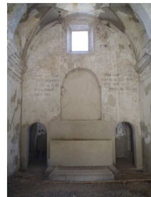
Vista de muro testero
