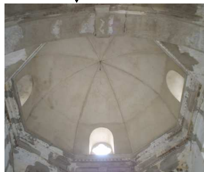
Vista interior de cúpula
