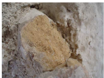
Piedra caliza localizada en muros
