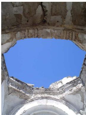
Foto interior de lo que era la cúpula
