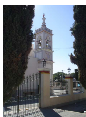
Vista de la torre de la iglesia
