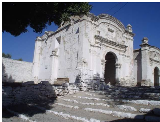
Vista de los aplanados y pintura a la cal
