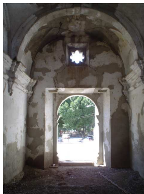
Vista de fachada interior
