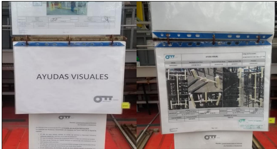
Figura 35 “Ayudas visuales” colocadas en el área de enrracado.
