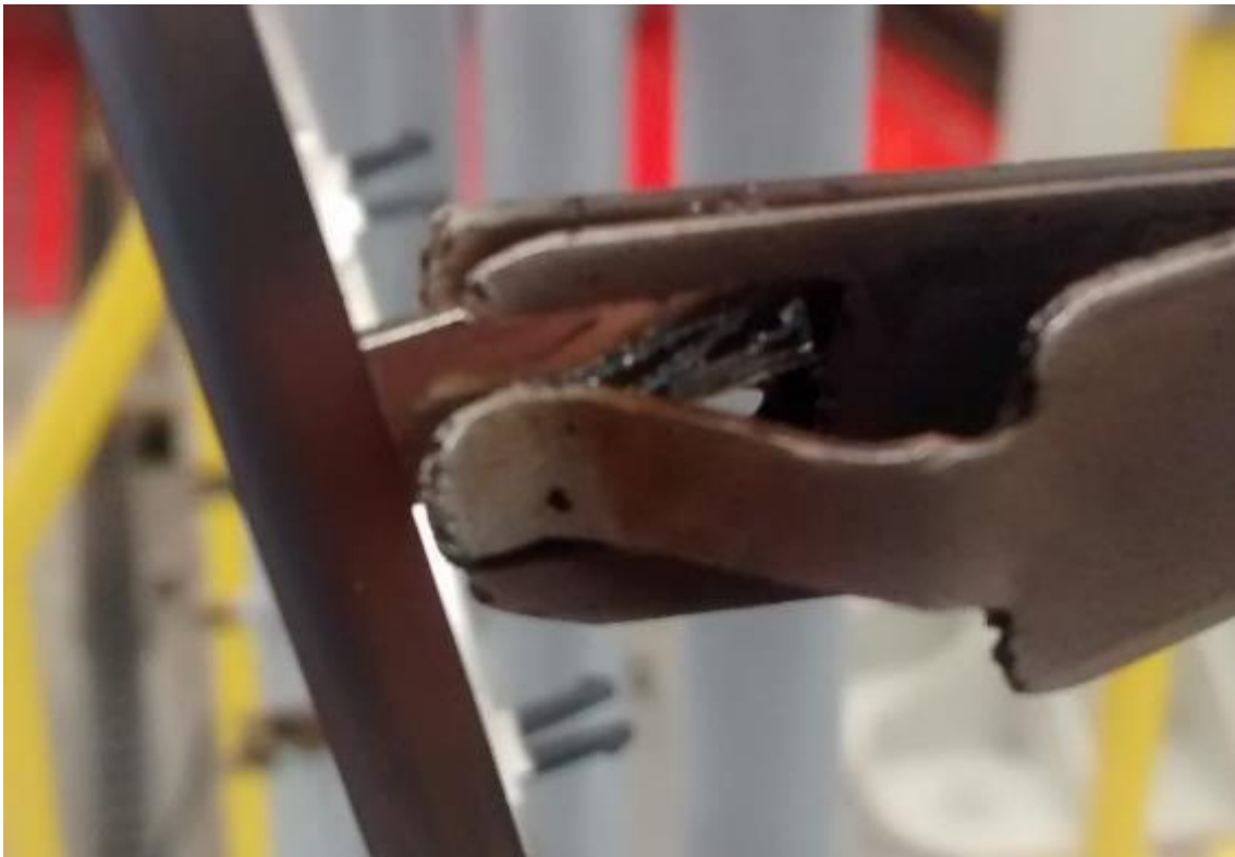
Figura 16 Punto de contacto y sujeción dañado con un deficiente agarre.
