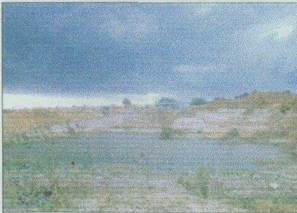
Imágen 27. ACCIDENTES NATURALES: En esta foto se muestra una acumulación de agua dentro del sitio causada por un cambio de nivel.
