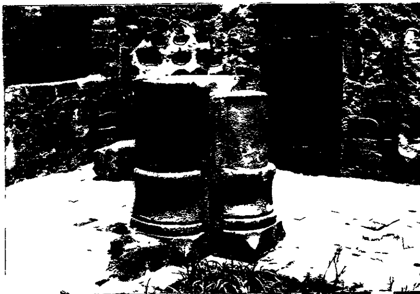
RESTOS DE COLUMNAS EN EL CLAUSTRO
