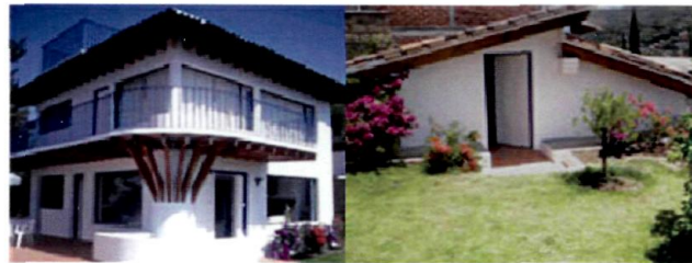
Fachadas de la Clínica San Marino
