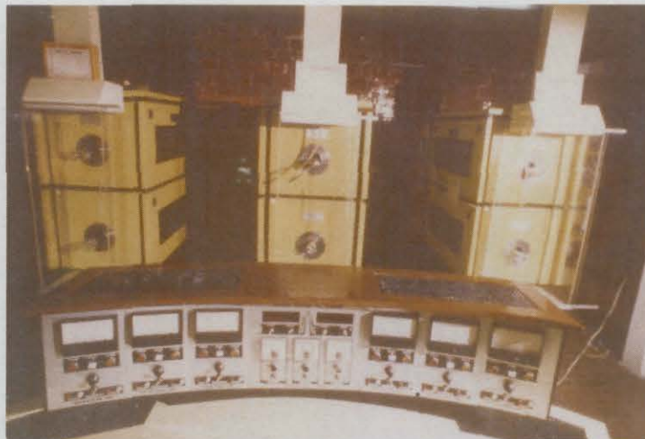
Figura 3. 23, Vista general de la sala de hornos con la consola de control de temperatura y tiempo.
