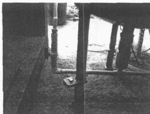
Figura 4.9 Instalación de Tubería
