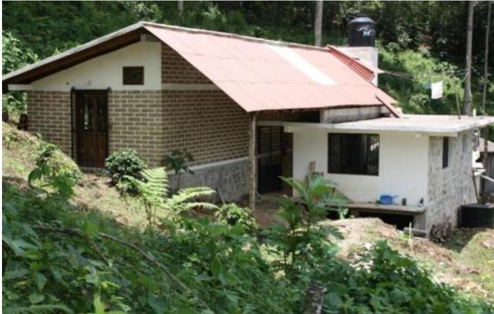
Casa construida con el apoyo del Programa de Vivienda de SCARTT y subsidio CONAVI, Cuetzalan, Puebla, 2012. Archivo fotográfico de SCARTT (Mora, 2012).
