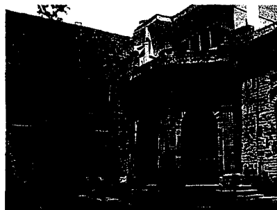
Pórtico fachada interior
