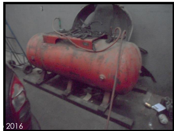
Equipo de compresión para la limpieza de piezas, para el área mecánica.
