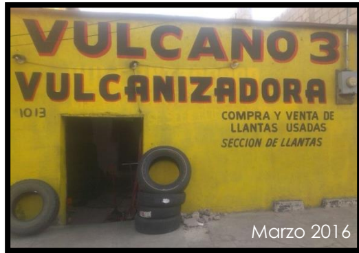
Fachada "Vulcano 3", vulcanizadora adaptada a casa habitación.
