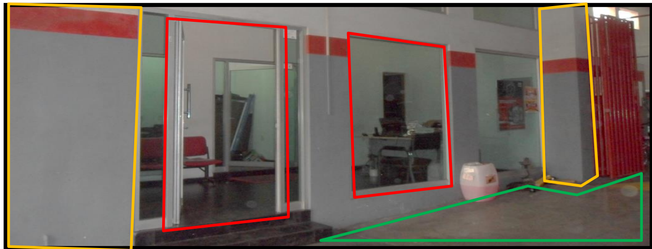
Muro de block revocado de concreto y pintado con los colores de la empresa.
