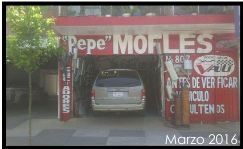
Fachada "Pepe" taller de mofles, que fue adaptado de una cochera de casa habitación.
