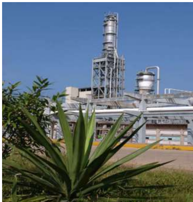
Figura 3.11. Planta Swing del Complejo Petroquímico Morelos.
