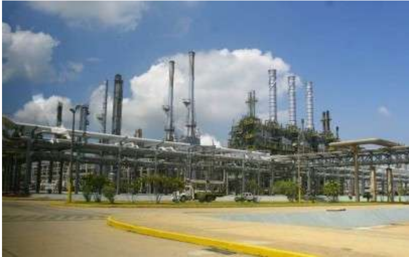
Figura 3.10. Complejo Petroquímico Morelos. Fuente: Pemex Petroquímica, 2007.
