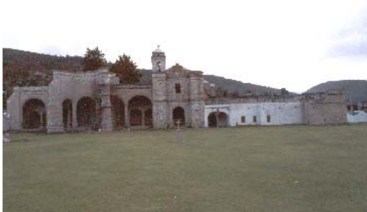
Vista general del convento y capilla abierta en Teposcolula Oaxaca/ Nov. 2003
