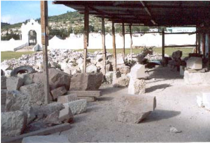
Labrado de piedra de cantería en el sitio para la restitución de material erosionado. Teposcolula Oaxaca. /Nov. 2003
