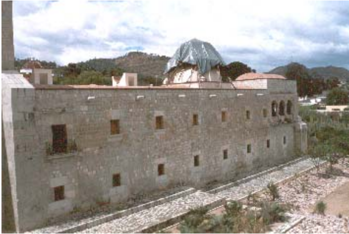
Vista de una cúpula del claustro en proceso de restauración. Ex convento de Santo Domingo en Oaxaca./ Nov. 2003
