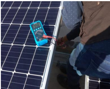
Fotografía 2 Mantenimiento de sistema
