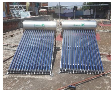
Fotografía 6 Calentadores solares
