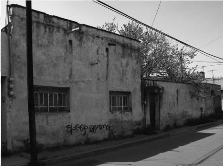
Imagen. Fachada principal
