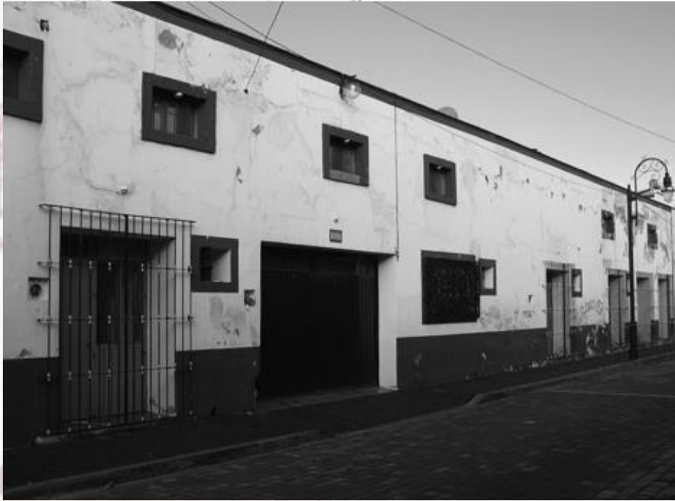
Imagen. Vista del acceso principal
