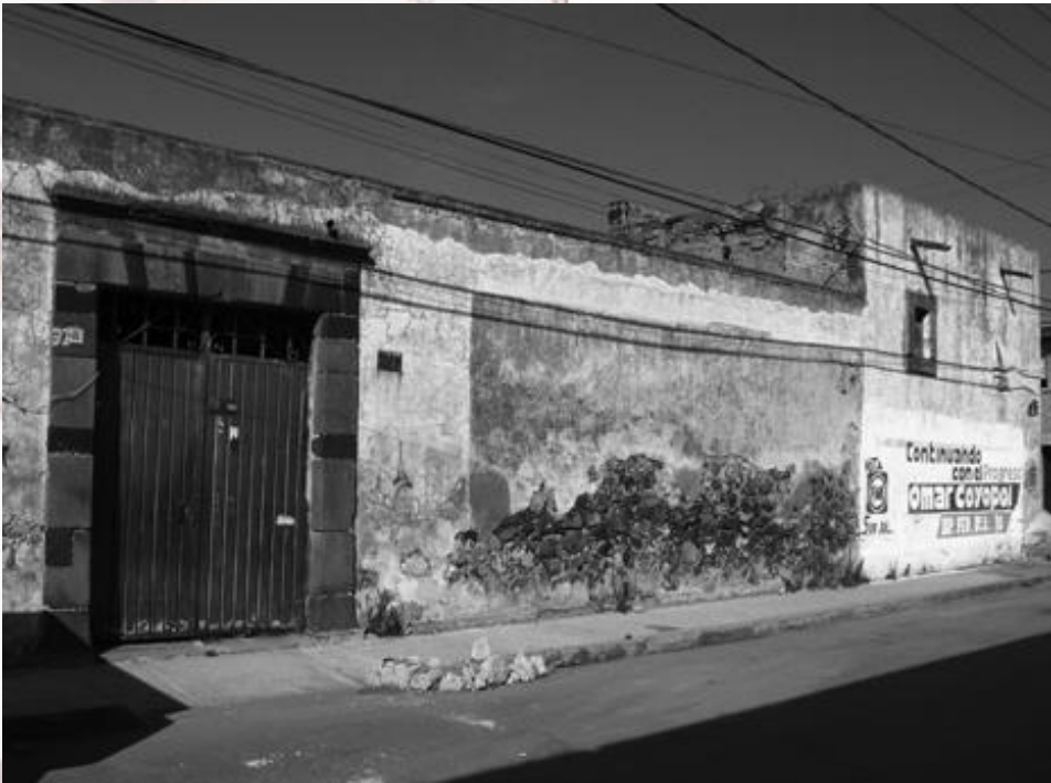
Imagen. Vista del acceso principal
