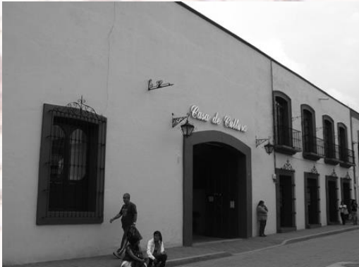
Imagen. Fachada principal
