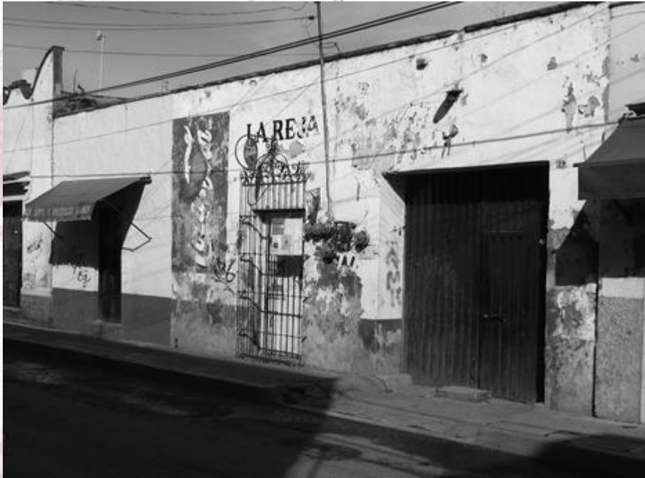
Imagen. Fachada principal
