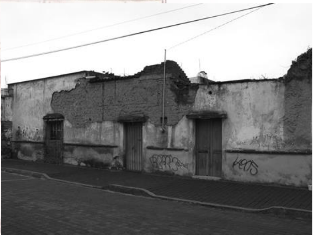
Imagen. Fachada principal
