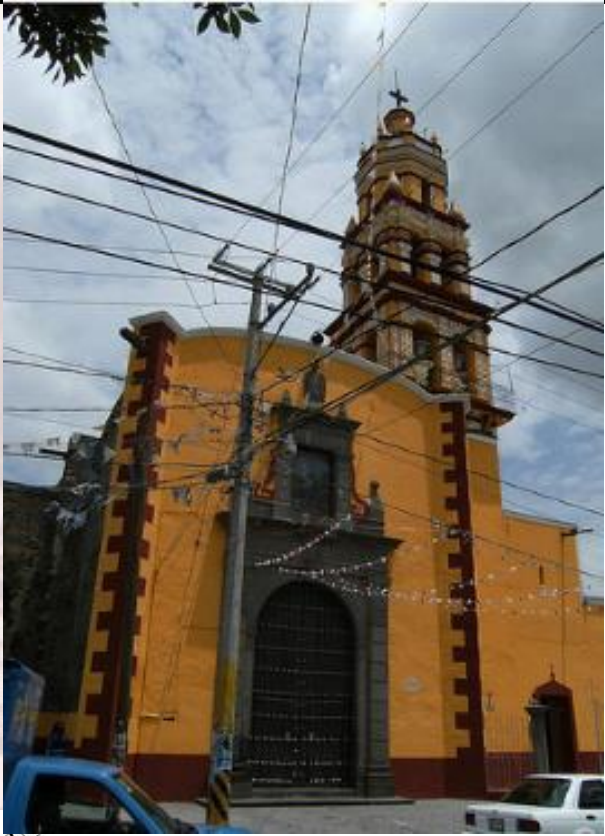
Imagen. Fachada principal
