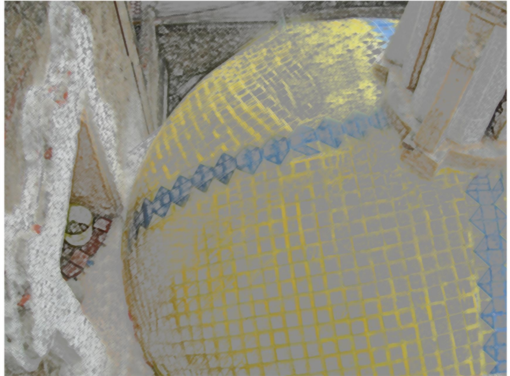
Imagen 1. Cúpula semiesférica o de media naranja, rematada por cupulín, parroquia de San Antonio de Padua, Acuamanala .
