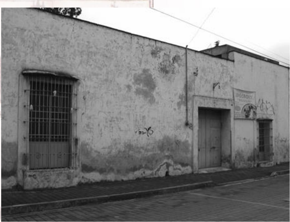
Imagen. Fachada principal
