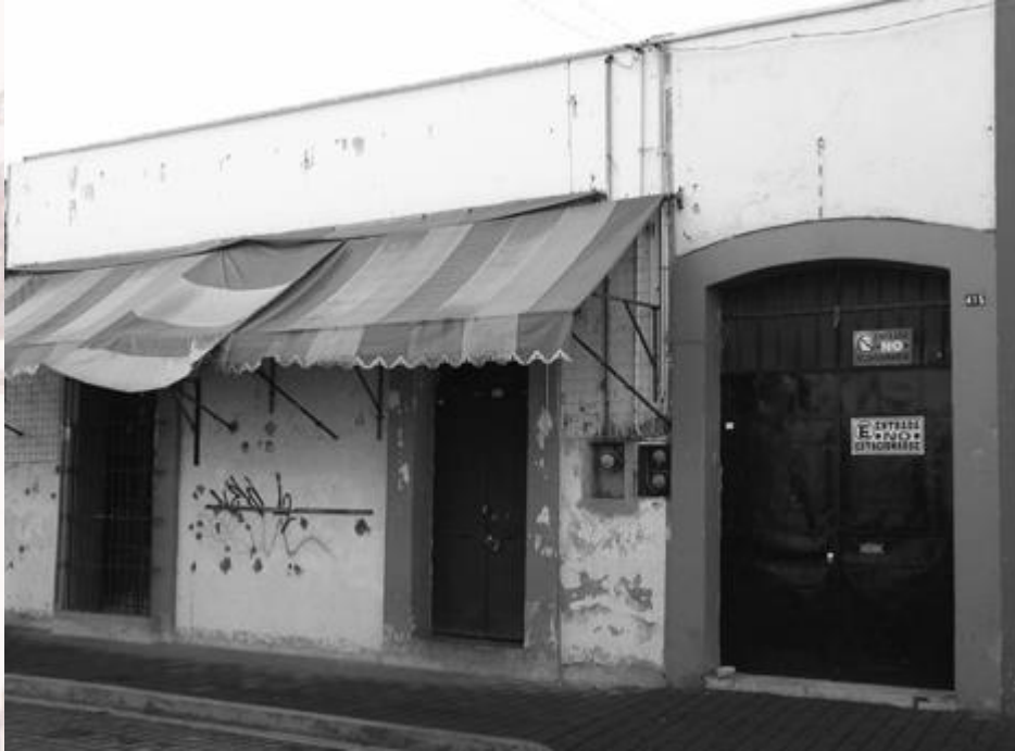
Imagen. Fachada principal
