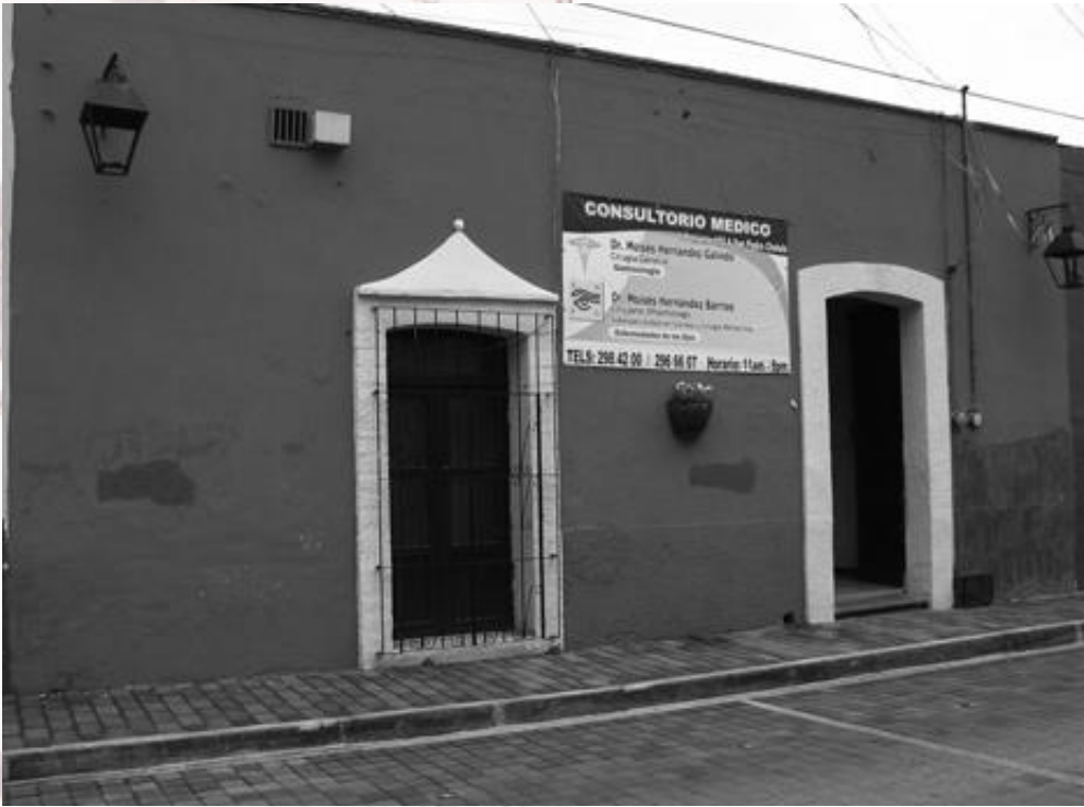
Imagen. Fachada principal
