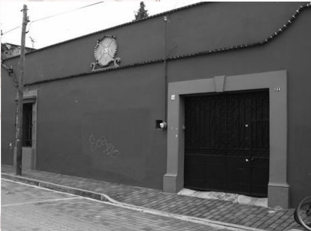
Imagen. Fachada principal
