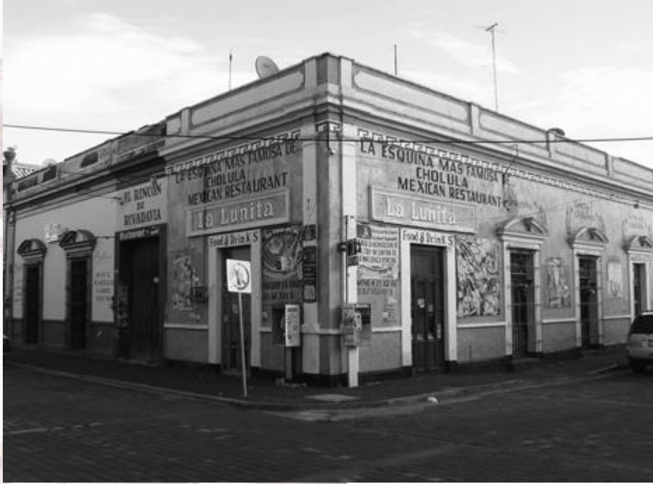
Imagen. Fachada principal
