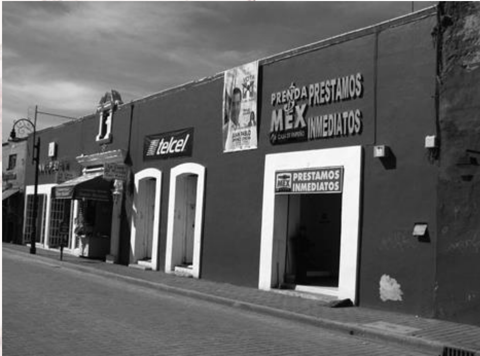
Imagen. Fachada principal
