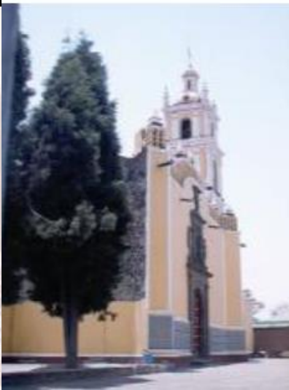
Imagen. Vista de la fachada principal
