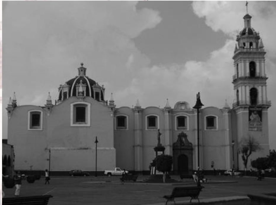
Imagen. Vista lateral del templo
