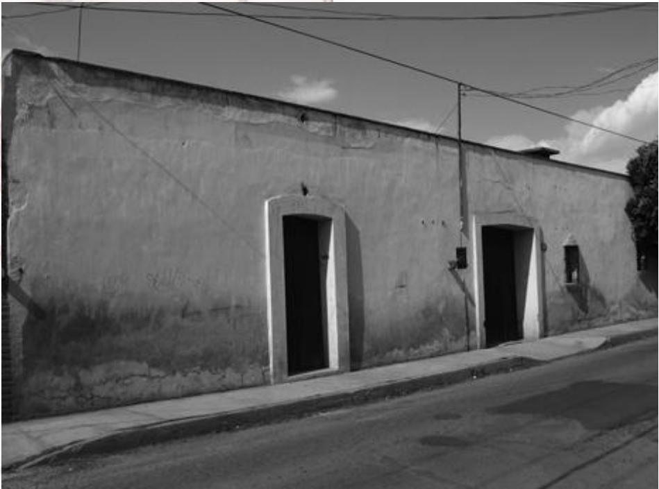
Imagen. Vista del acceso principal
