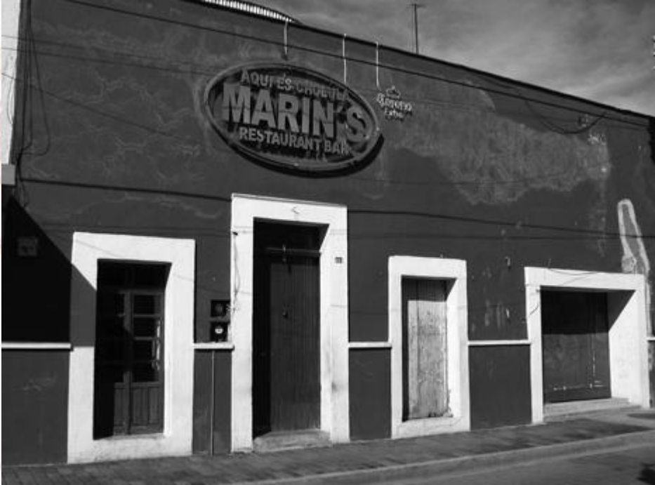
Imagen. Fachada principal
