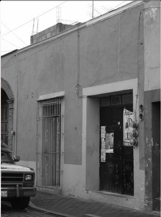
Imagen. Fachada principal
