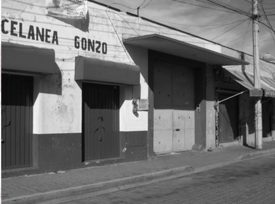
Imagen. Fachada principal
