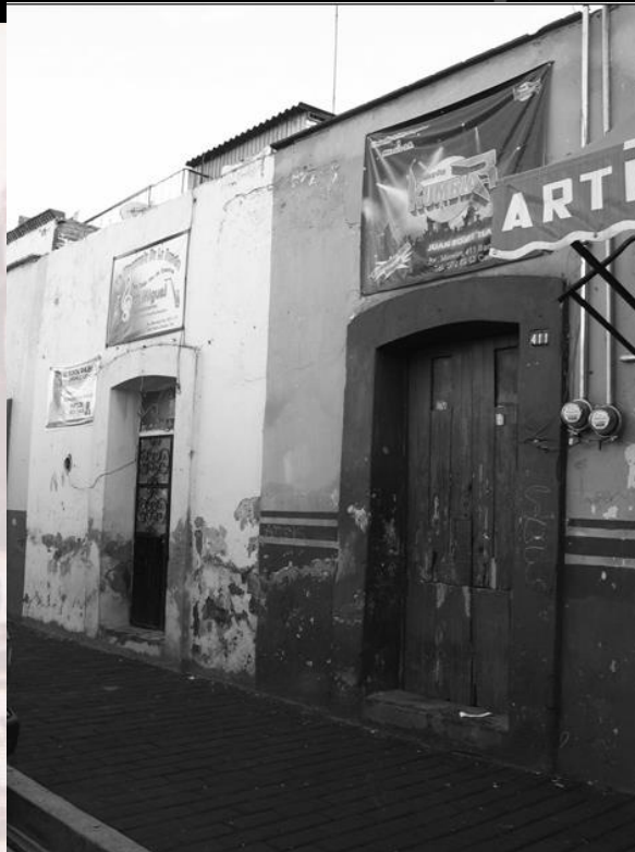
Imagen. Fachada principal
