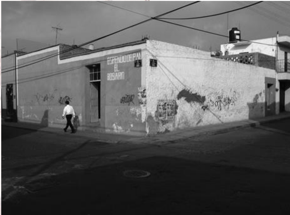
Imagen. Vista de las dos caras del inmueble
