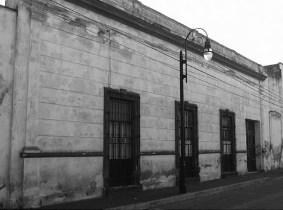
Imagen. Vista del acceso principal
