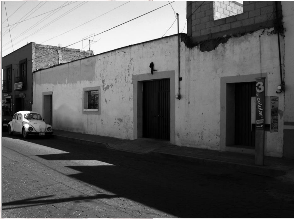
Imagen. Fachada principal
