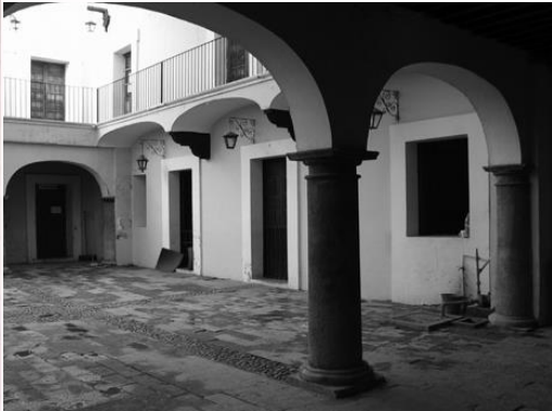
Imagen. Patio interior
