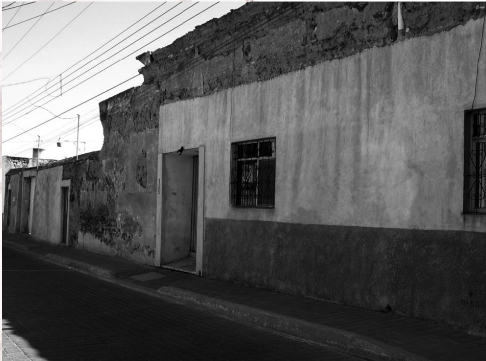
Imagen. Fachada principal
