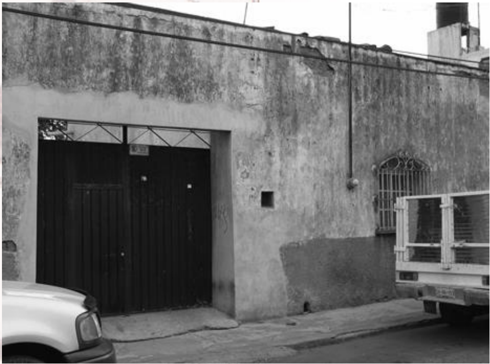
Imagen. Vista del acceso principal
