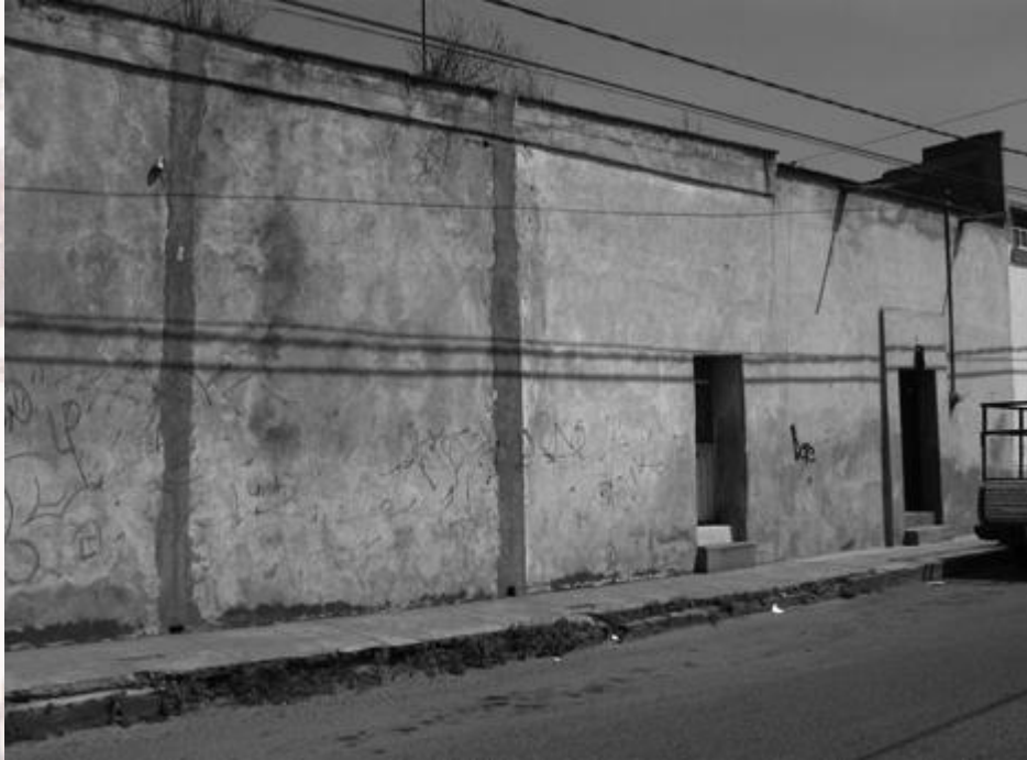
Imagen. Fachada principal
