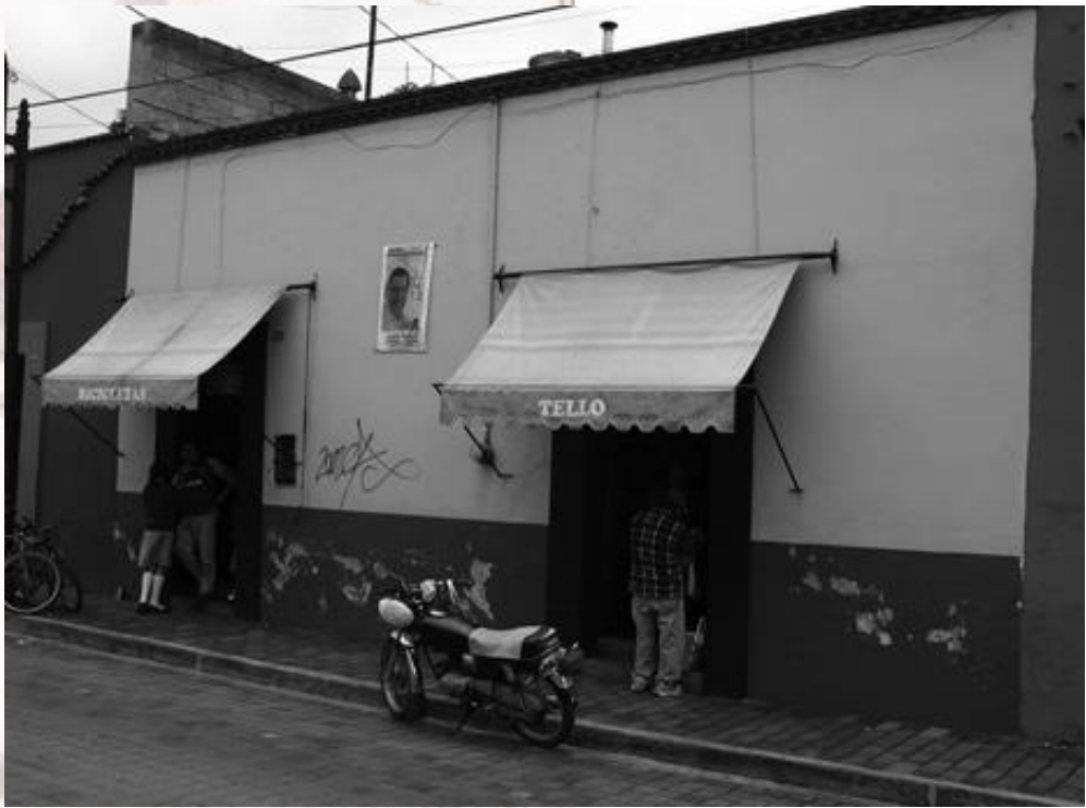
Imagen. Fachada principal
