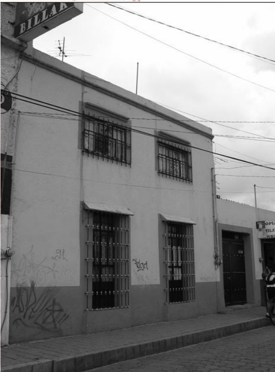
Imagen. Fachada principal
