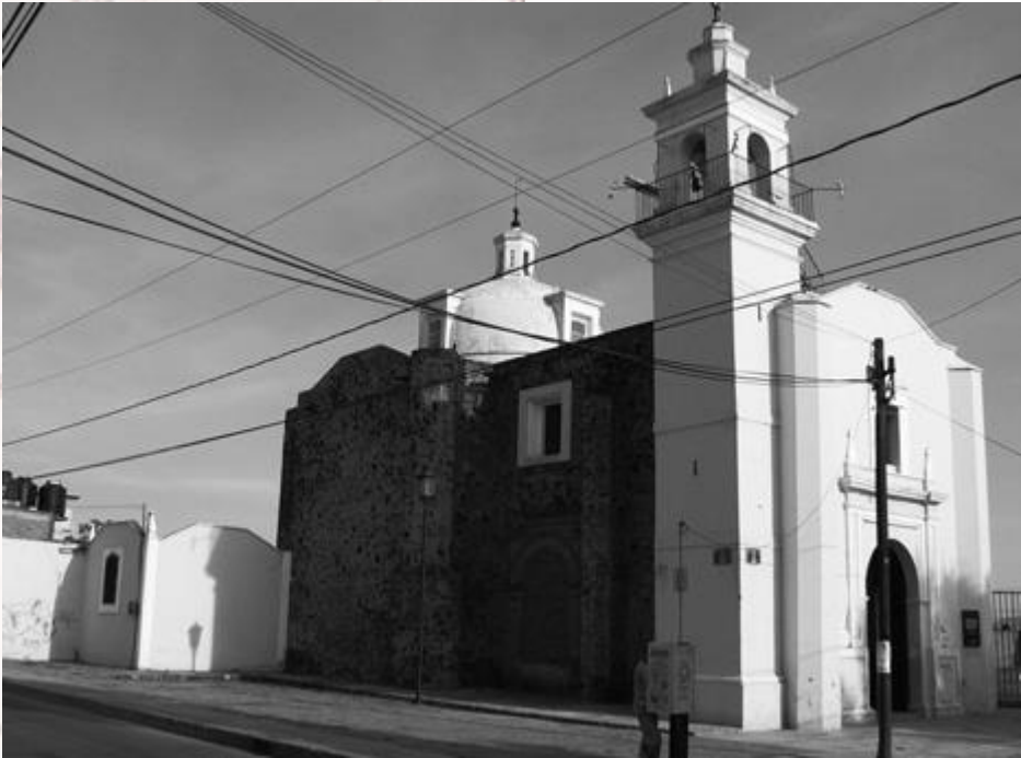
Imagen. Vista de la fachada principal y cara lateral
