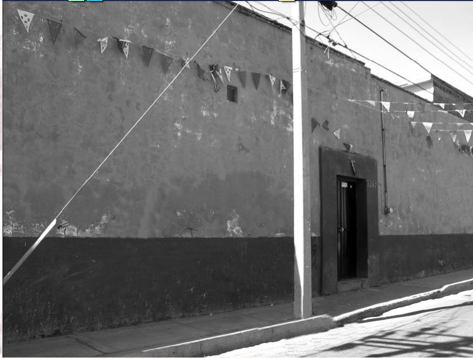
Imagen. Fachada principal
