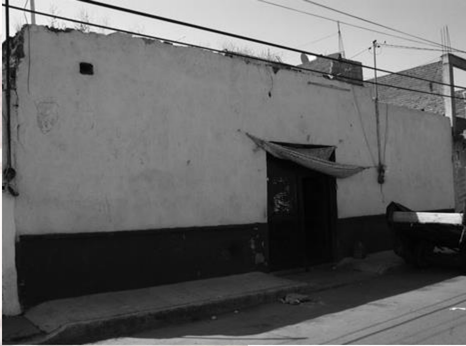
Imagen. Fachada principal
