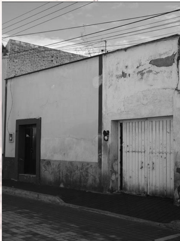
Imagen. Vista del acceso principal
