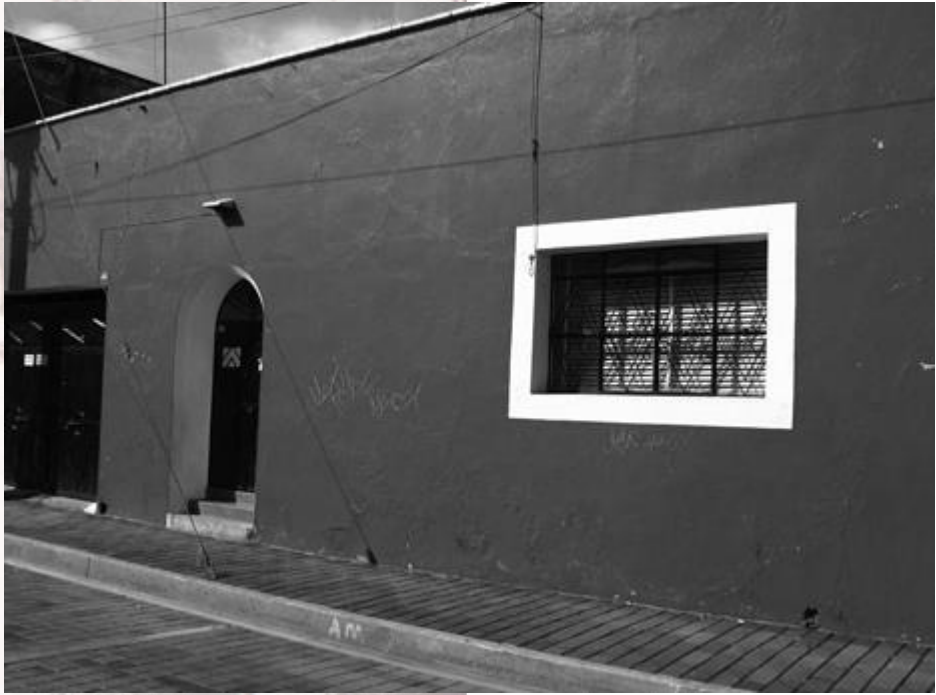
Imagen. Fachada principal
