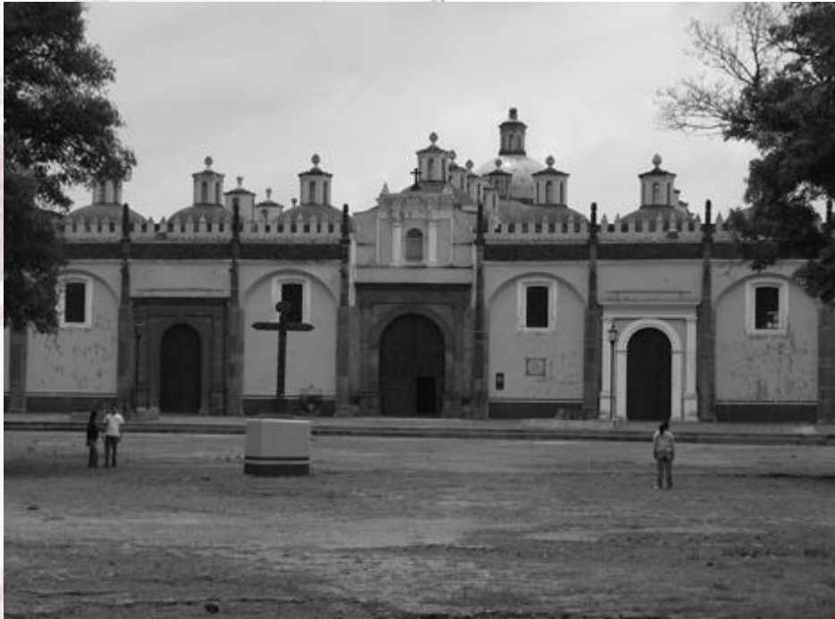
Imagen. Fachada principal
