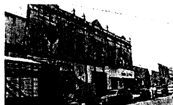
Centro Histórico de Puebla. Degradación de la Imagen Urbana por deterioro a falta de mantenimiento, así como cambio de uso de suelo de habitacional a comercial o mixto. Pintura de esmalte y rótulos comerciales fuera de la normativa.
