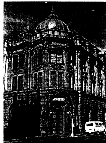
Edificio de Protocolos del Gobierno del Estado de Puebla. Av. Juan de Palafox y Mendoza esq. 2 norte, ejemplo de arquitectura ecléctica del primer tercio del siglo XX.
