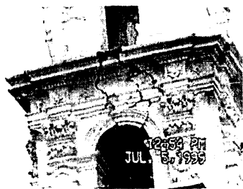
Torre del templo de San Jerónimo, daños del sismo de 1999
