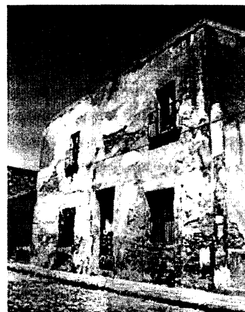
Centro Histórico de Puebla. Degradación por abandono de los inmuebles.
