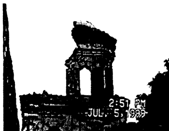
Torre del templo de San Agustín, daños del sismo de 1999
