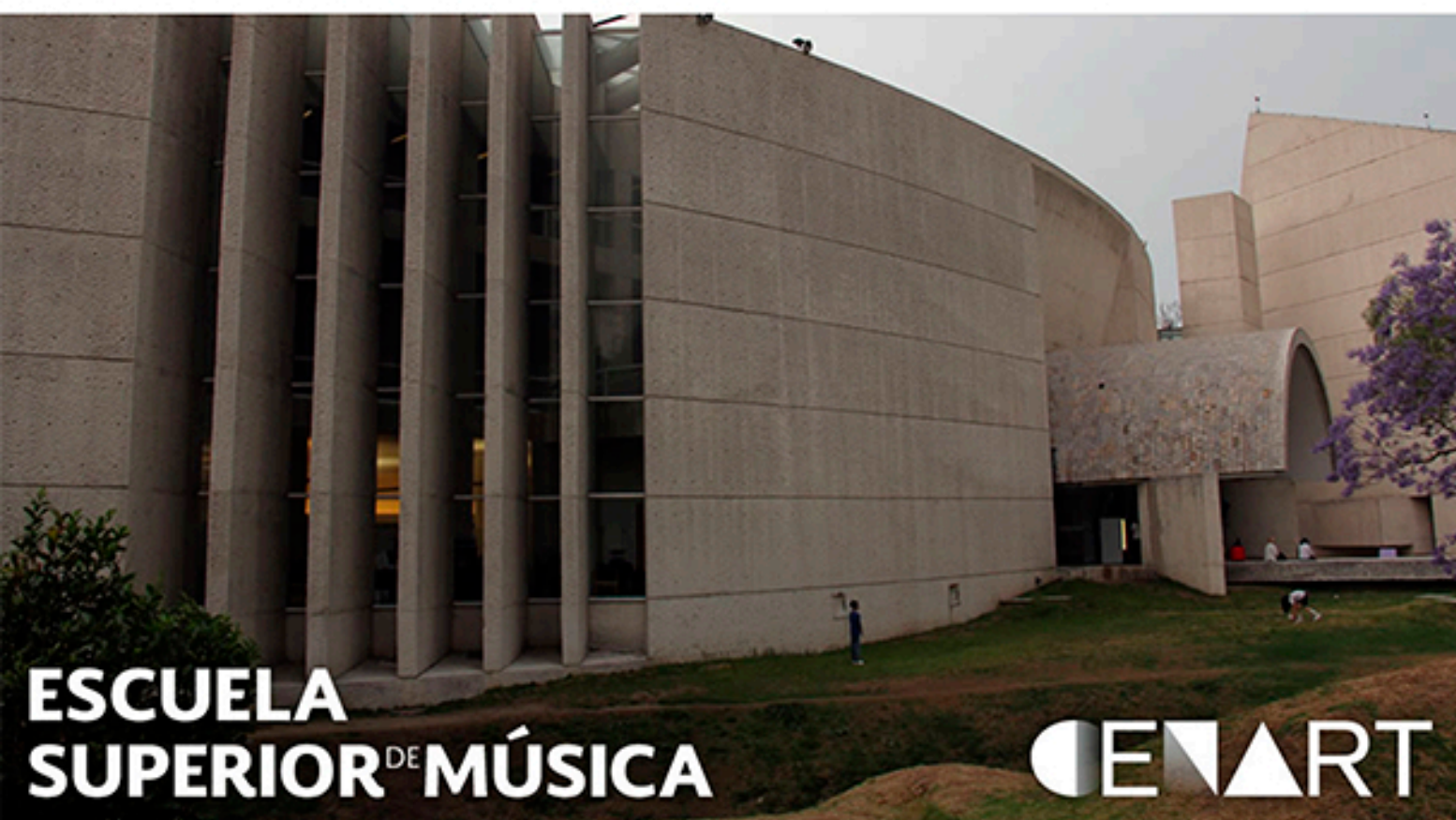
Imagen 51. Fachada de la Escuela Superior de Música.
