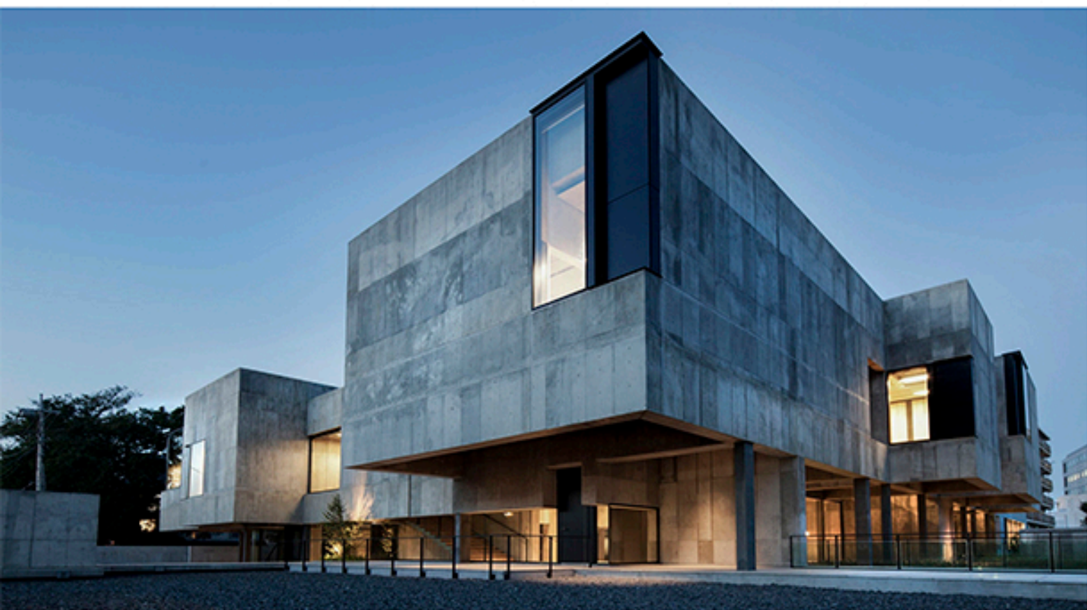
Imagen 32. Fachada de la Escuela de Música Tohogakuen.
