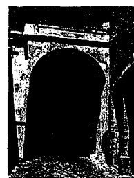
Acceso principal San Manuel
