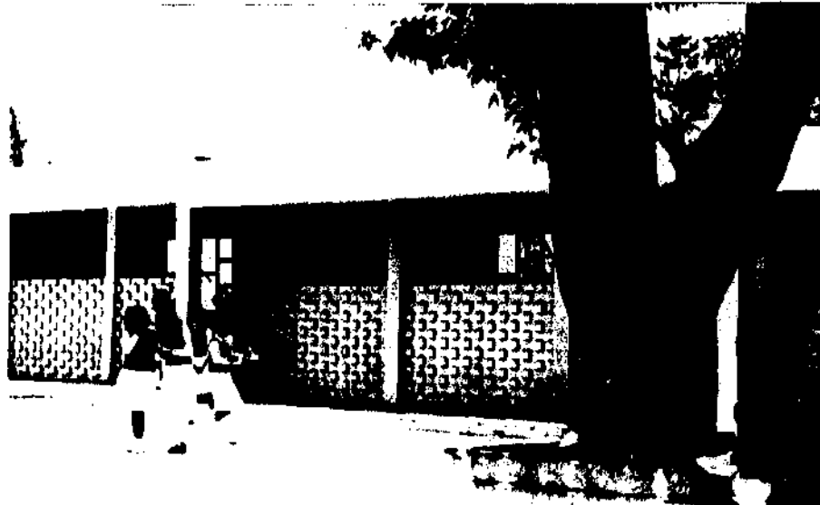
SECUNDARIA POR COOPERACION
