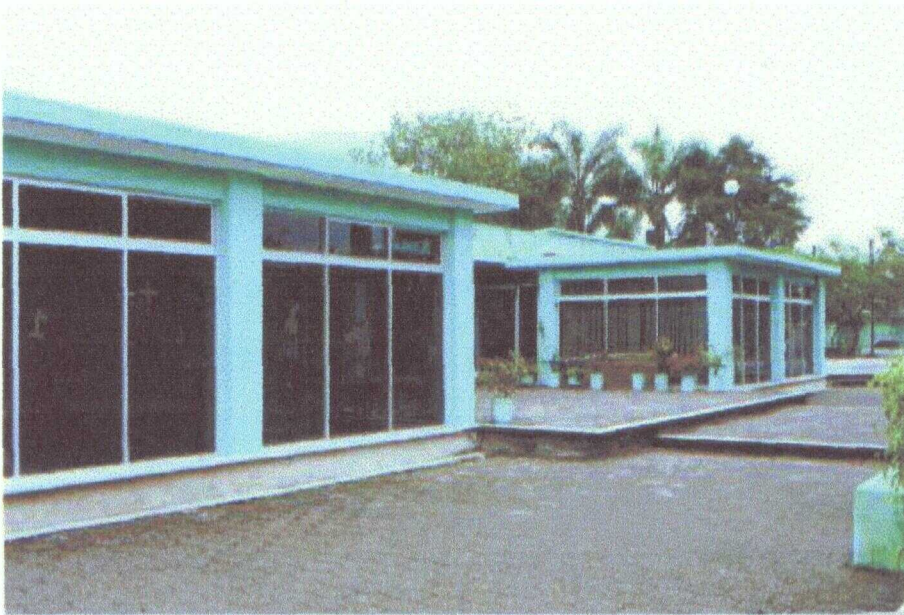
FACHADA PRINCIPAL. (SUR)
