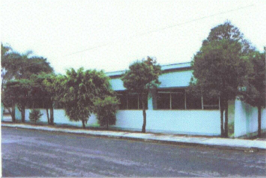
FACHADA POSTERIOR. (NORTE)
