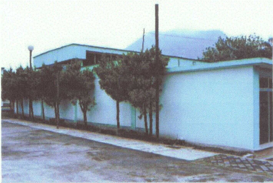
FACHADA LATERAL. (PONIENTE)
