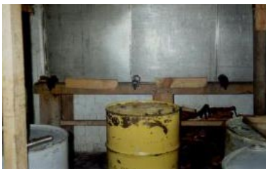
Llenado de tambos a través del tanque de sedimentación.
