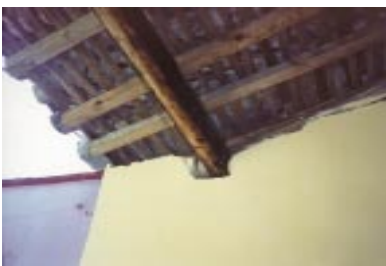
Techo tradicional de vigas de madera y teja
