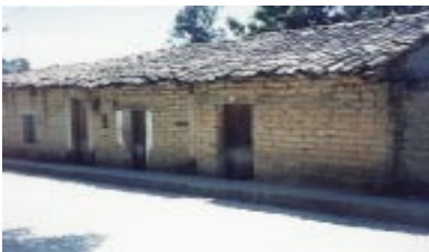
Casa hecha con muros de adobe y techo de teja. Los cerramientos de las puertas están hechos con vigas de madera
