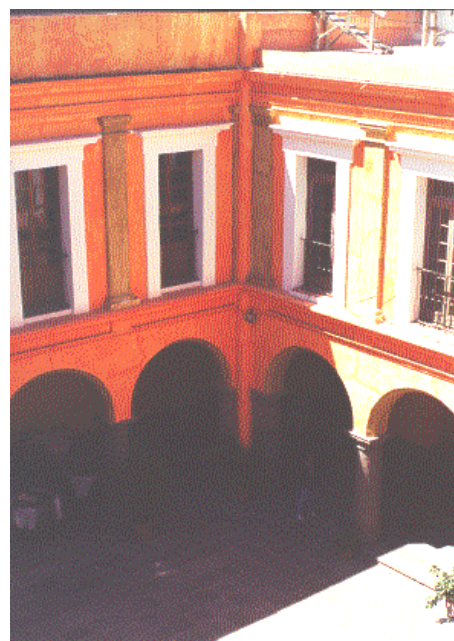
Arcos de medio punto y platabandas doveladas
