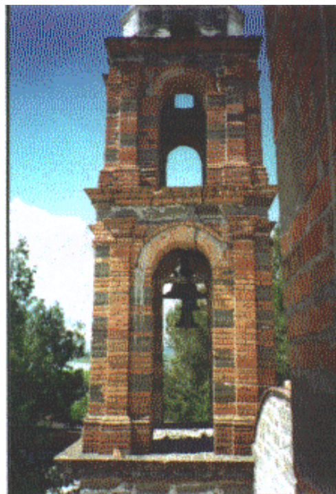
Utilización de ladrillo como parte de elementos estructurales
