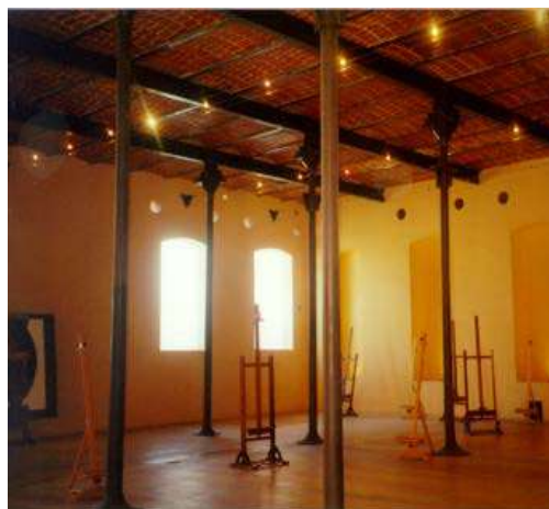
Cubierta a base de bovedilla de ladrillo
