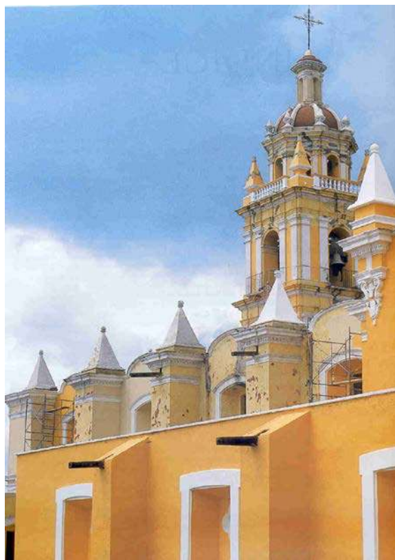
La utilización de morteros de cal y arena como aplanados permite la protección de los elementos estructurales.
