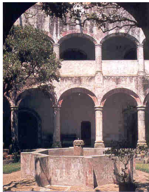
Claustro de Huejotzingo. Ejemplo de columnas como apoyos aislados.
