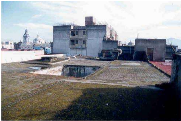
VISTA GENERAL DE AZOTEA
