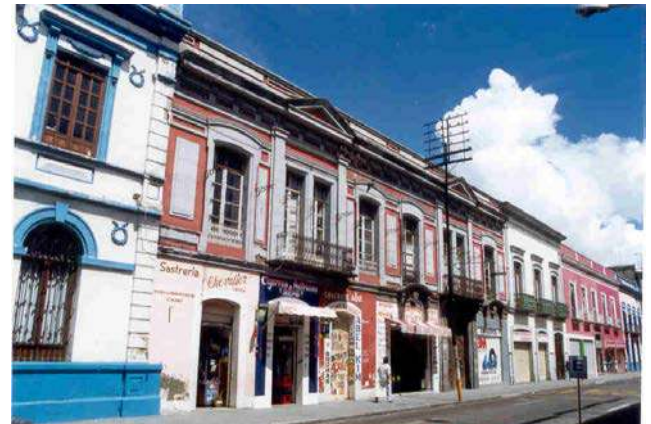
FACHADA PRINCIPAL AV. 2 PONIENTE
