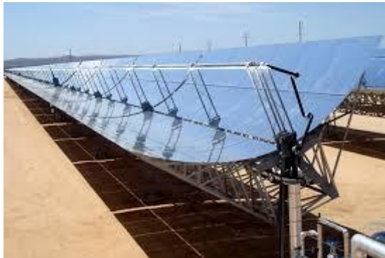
Fig. 2.14. Colector lineal de tubo.
