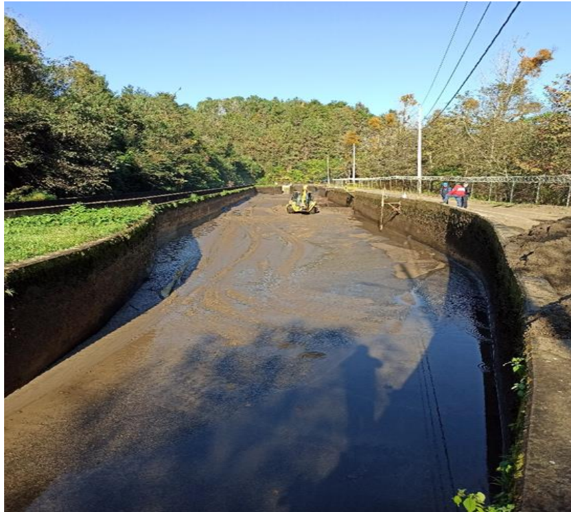
Ilustración 6 Limpieza de sólidos del desarenador. Atexcaco, 2021.
