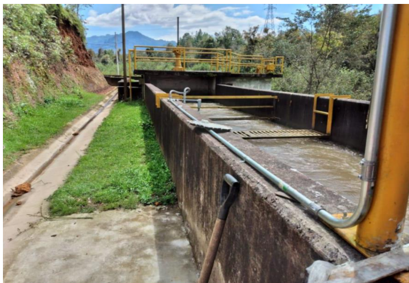
Ilustración 10 Canalización de sensores de nivel de agua. Atexcaco, 2021.
