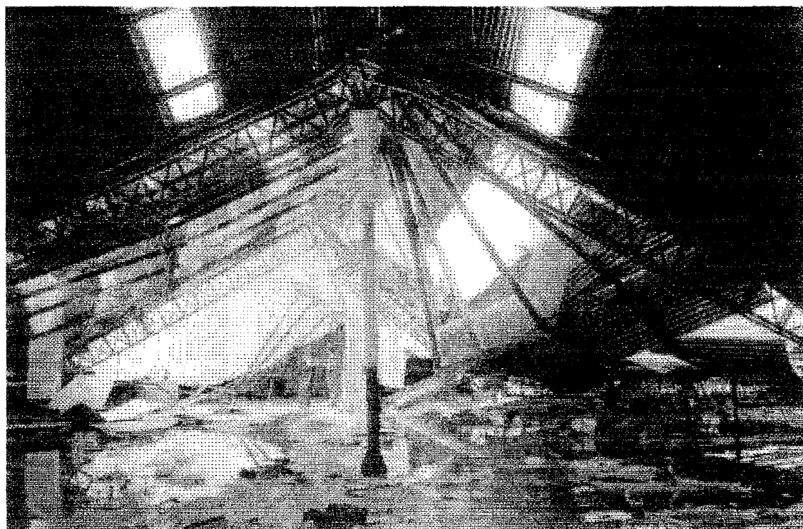
(foto 8 1 4 Falla de trabes secundarias)
