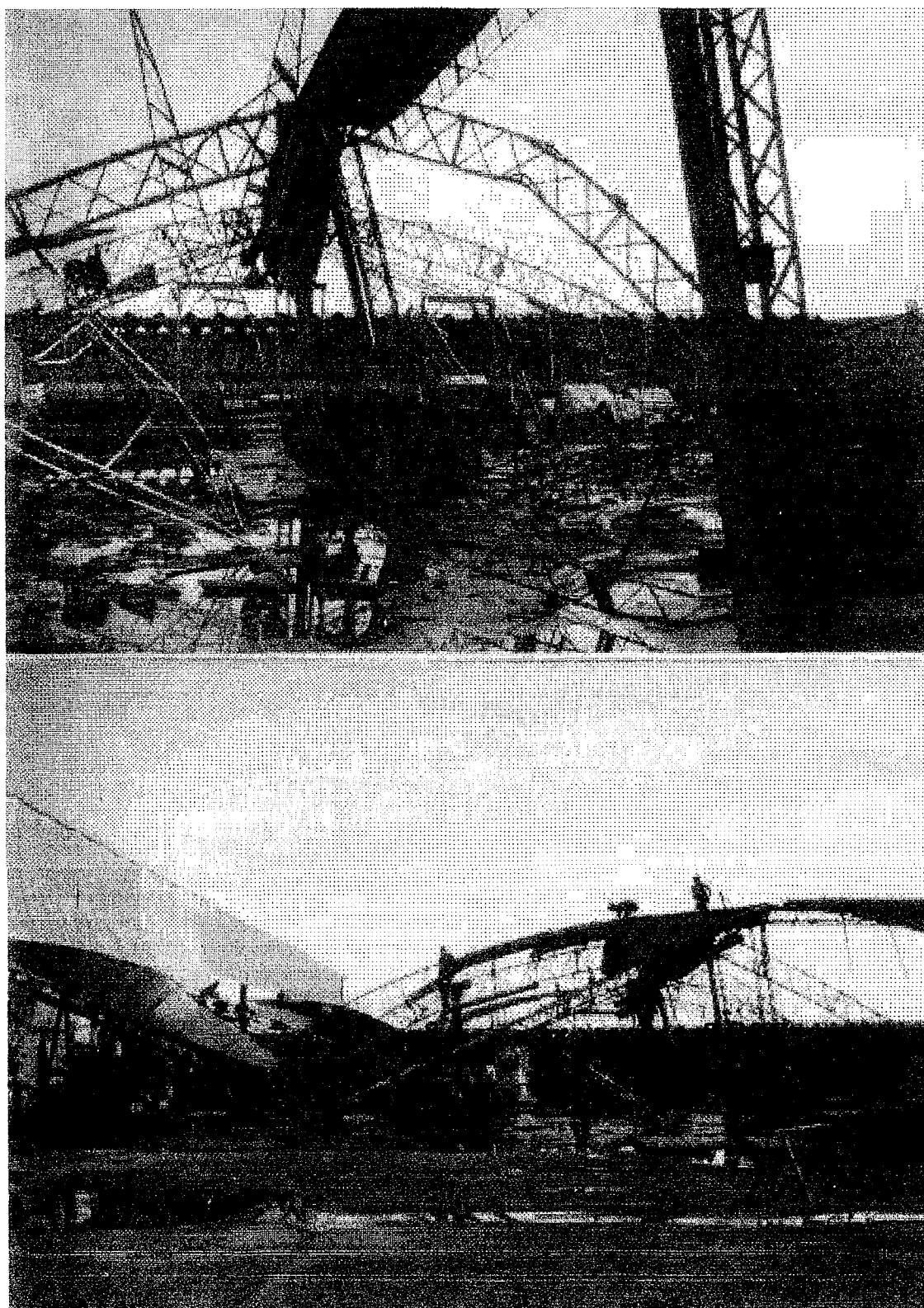
(Figura 2 3-4 Nave Industrial Colapsada)
