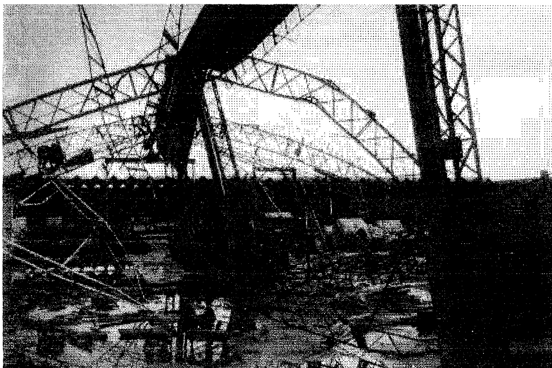
(foto 8 1 1 Falla Estructural en cubierta)
