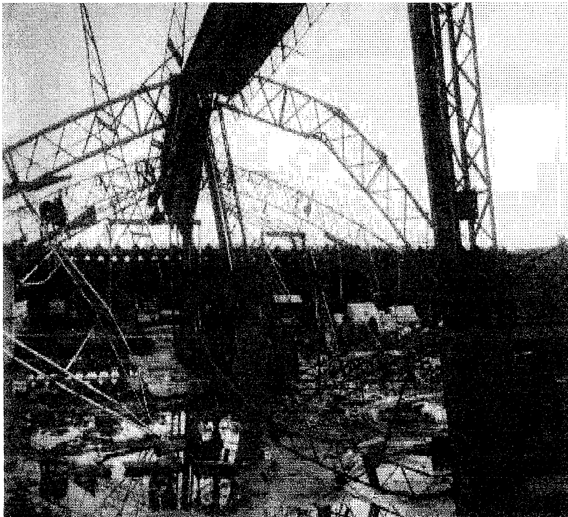
(Figura 1 3 nave industrial colapsada)
