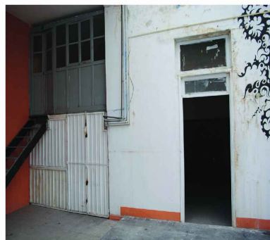
31 AREA DE ESCALERAS
