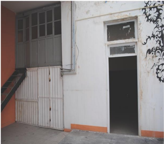
31 AREA DE ESCALERAS
