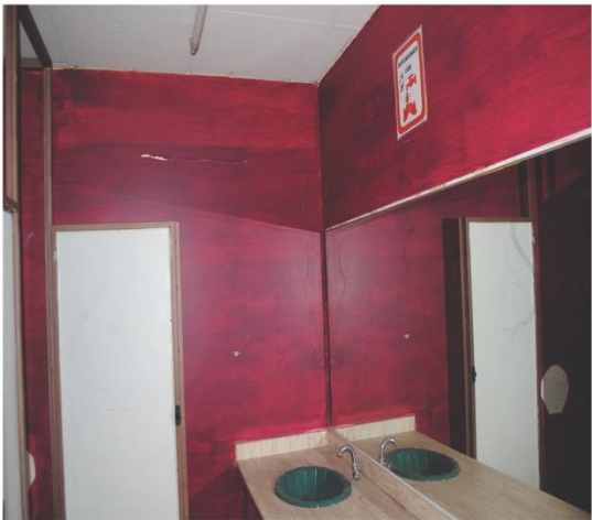
68 VISTA INTERIOR SANITARIOS PLANTA ALTA
