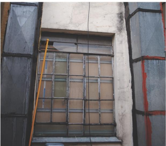
72 VENTANA DE SANITARIOS PLANTA ALTA
