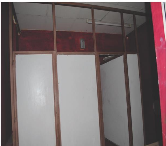
69 VISTA INTERIOR SANITARIOS PLANTA ALTA
