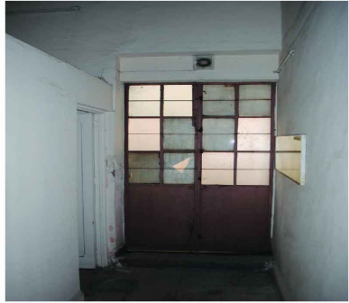
44 ACCESO AL PATIO
