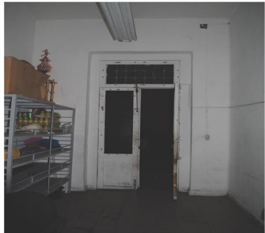
46 INTERIOR OFICINA PLANTA ALTA
