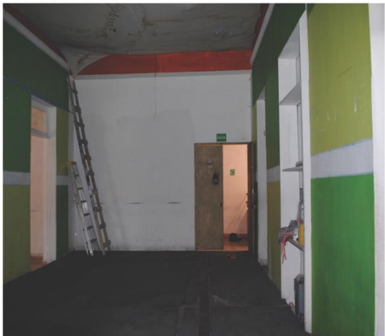
51 VISTA DEL PATIO INTERIOR
