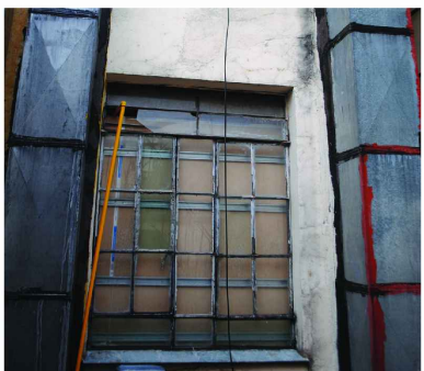
72 VENTANA DE SANITARIOS PLANTA ALTA
