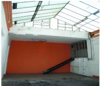
42 VISTA DEL PATIO INTERIOR
