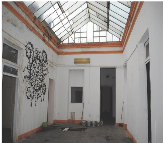
30 VISTA DE PATIO INTERIOR
