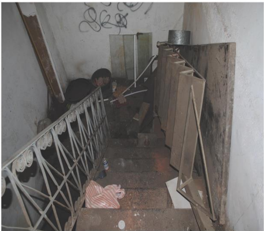
33 VISTA INTERIOR DE LAS ESCALERAS
