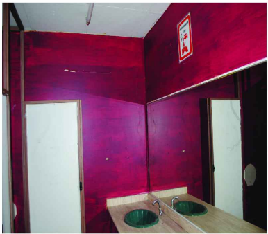
68 VISTA INTERIOR SANITARIOS PLANTA ALTA
