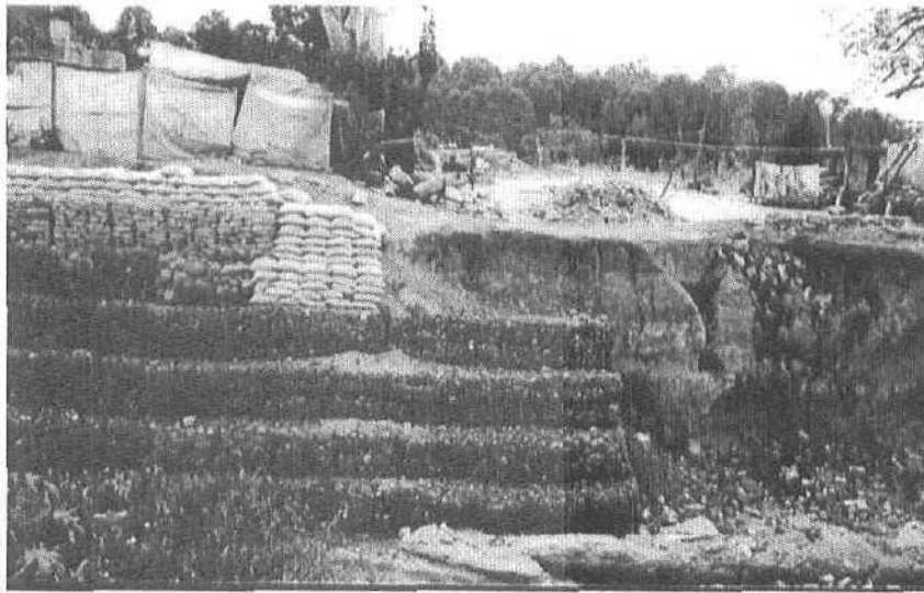
ESQUEMA N° 18: ENCAUSAMIENTO REALIZADO CON PIEDRA Y MALLA, EN LA COLONIA LA PROVIDENCIA
