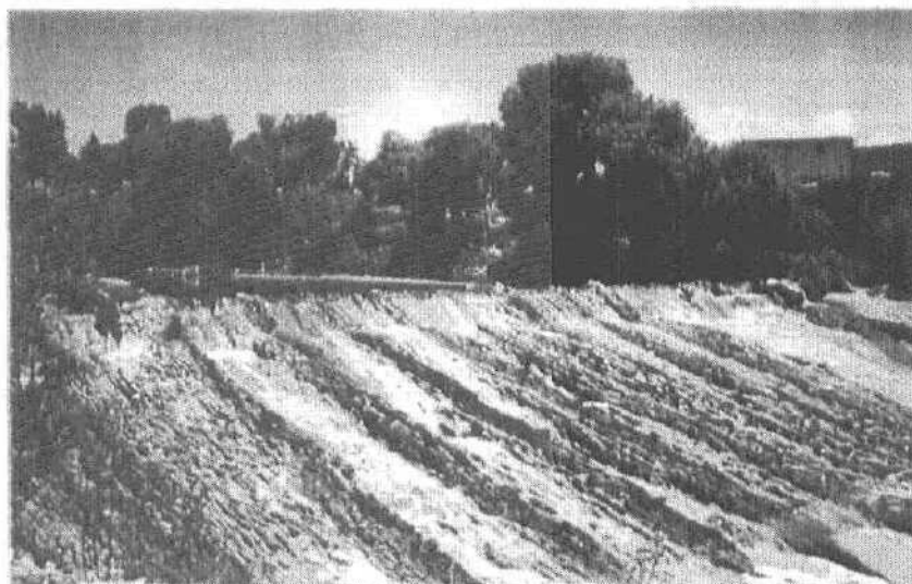
ESQUEMA N° 35: LAVADERO UBICADO AL FINAL DE LA CALLE 41 ORIENTE. COL. EL ESFUERZO.
