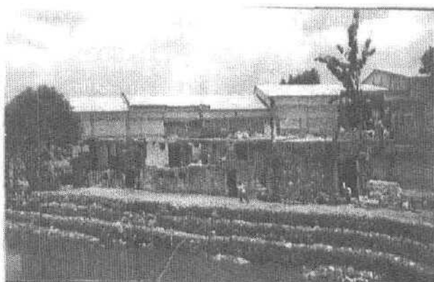
ESQUEMA N° 46: viviendas ubicadas en l borde del río, sufre erosión el talud, fue reconstruido recientemente, col. Vicente suarez.
