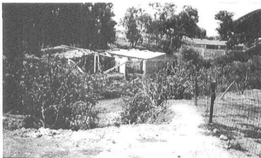
ESQUEMA N° 23: CONSTRUCCION LOCALIZADA EN UN TRAMO DONDE EL RIO EXPLAYA SU CAUCE FRENTE LA CALLE 29 OTE., COL. JOSE L. PORTILLO.
