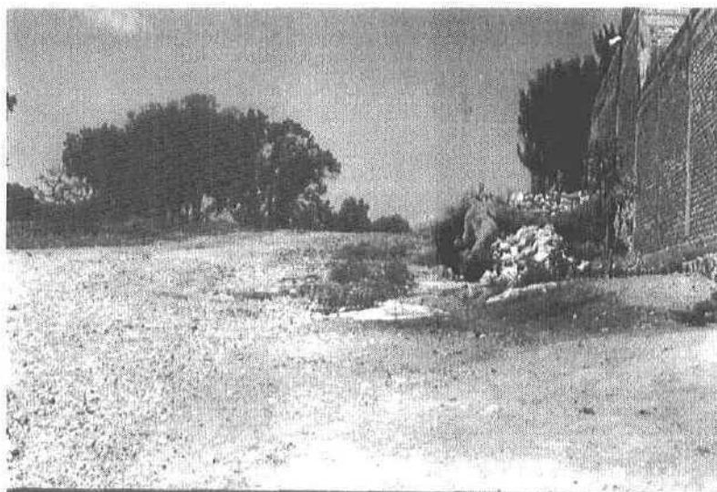
ESQUEMA Nº 27: TERRENO FALSO, CONSTRUIDO CON ESCOMBRO Y AÑOS DE PACIENCIA Y ESFUERZO, SIN NINGUNA TECNICA CERTIFICADA.
