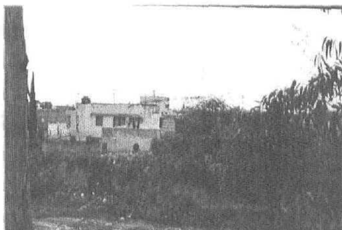
ESQUEMA N° 52: Calle 35 sur entre la 25 y la 29 oriente. Fachada posterior de las viviendas expuestas a la erosión del río.
