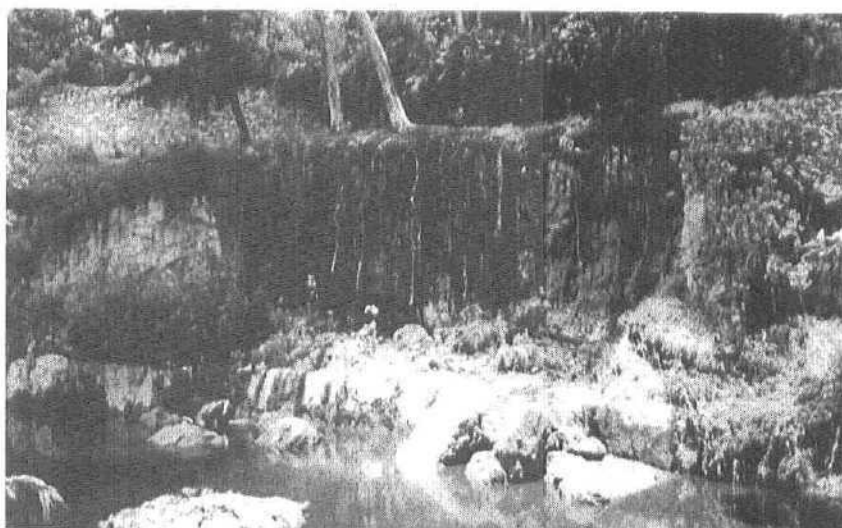
ESQUEMA N° 16: MUESTRA DE LA EROSION NATURAL DEL TALUD EN EL RIO ALSESECA, UBICADO A LA ALTURA DE LA UNIDAD GUADALUPE
