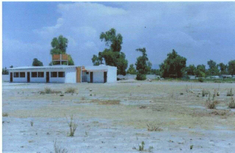
FOTO 19. VISTA OTRAS AULAS Y BAÑOS
