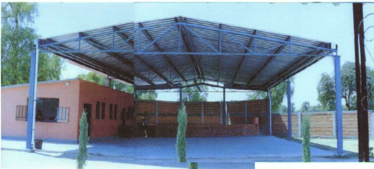
FOTO 17. PATIO TECHADO DE USOS MULTIPLES
