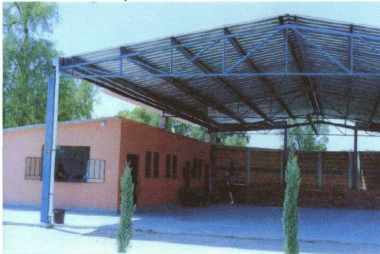
FOTO 16. VISTA DE LA COCINA Y CAFETERIA
