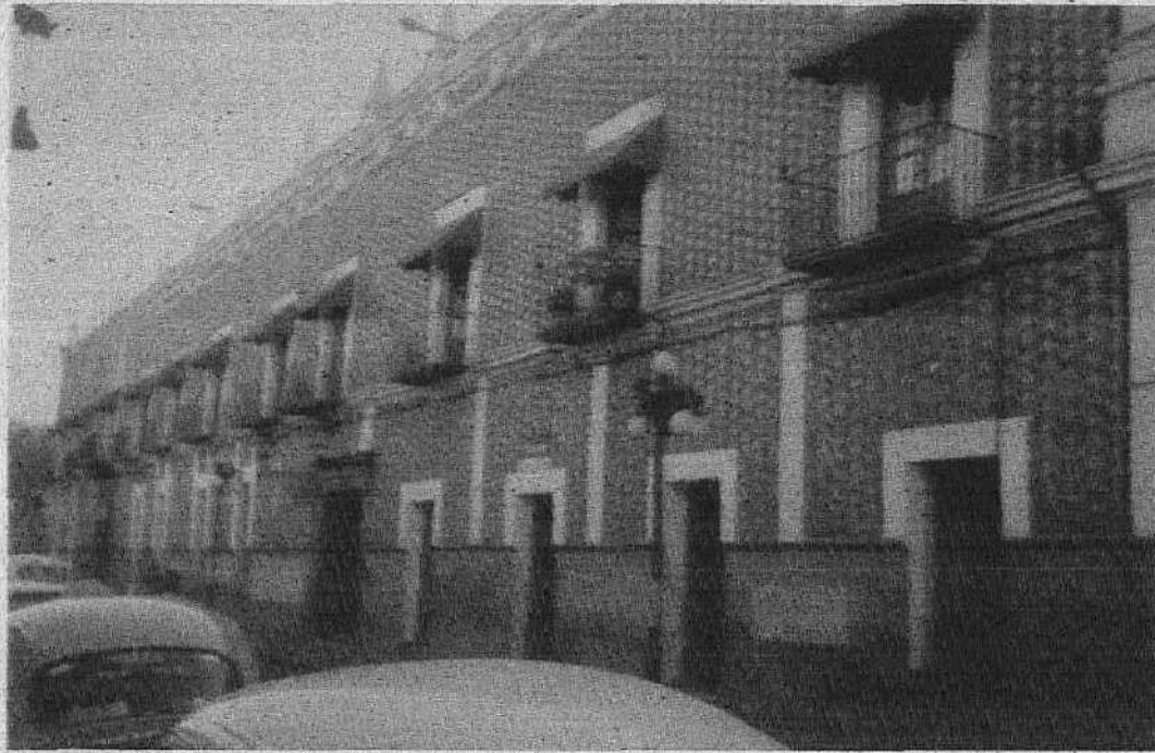
EDIFICIO DE CORREOS
