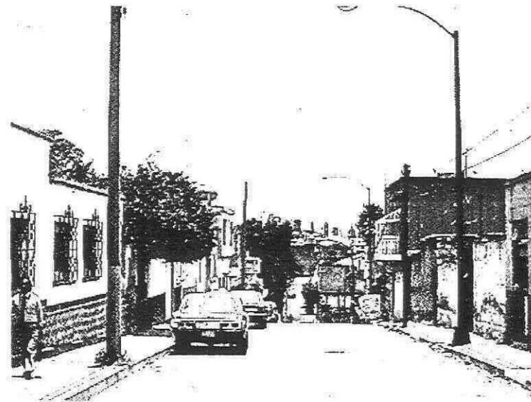
PENDIENTE HACIA EL ANTIGUO CAUCE DEL ARROYO XONACA
