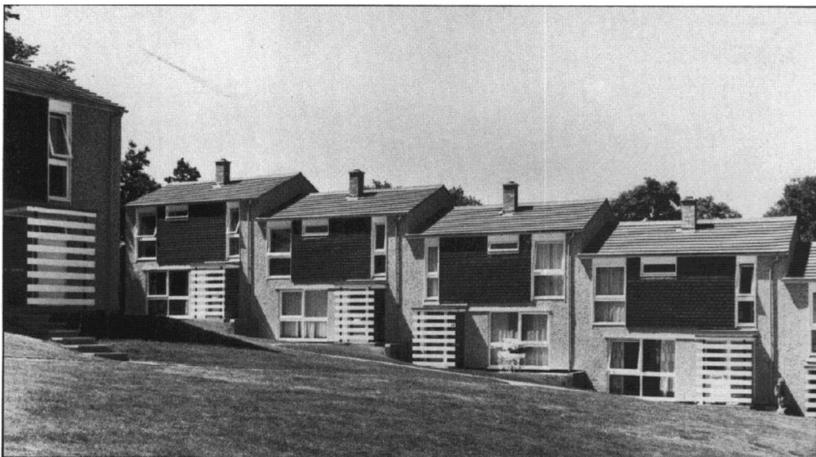
Figura 13.20. Casas en Sussex, Inglaterra con muros de concreto ligero sin finos colado in-situ.
