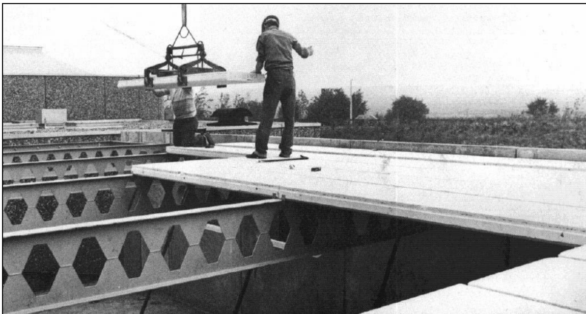
Figura 13.24. Unidades de concreto aerado precolado (Siporex) para losas en la ampliación de una escuela en Stanford-le-Hope, Essex, Inglaterra.
