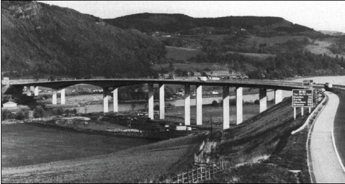
Figura 13.29. Puente Friarton de la autopista en Perth, Escocia. La cubierta es de concreto de agregado ligero (Lyttag).
