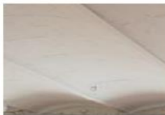
Bóveda Catalana Pintada de Blanco
