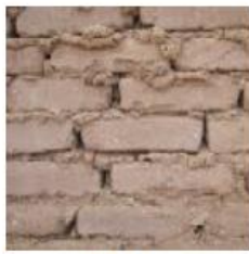
Adobe Exposto (Muros de Recamaras y exteriores Área Antigua)
