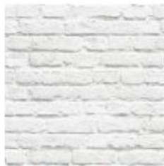
Ladrillo Pintado de Blanco (Área de Baños de recamaras y Pasillo Área Nueva)
