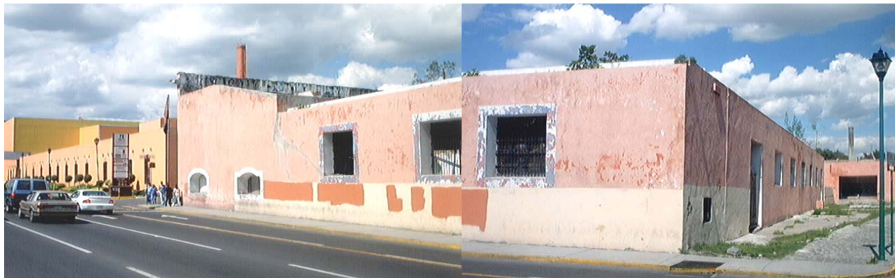
FACHADA PONIENTE DE LA FÁBRICA, Boulevard 5 de Mayo Y FACHADA SUR, Avenida Xonaca
