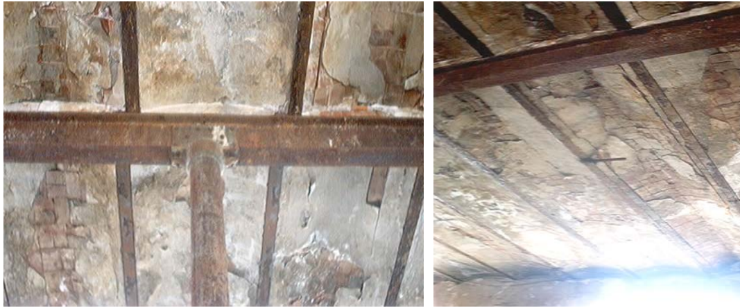
Arriba. ESTADO DE LA ESTRUCTURA METÁLICA, VIGAS, LARGUEROS Y COLUMNA CON CAPITEL ESTADO DE LAS BÓVEDAS DE TABIQUE, TIPO CATALÁN EN SUS MATERIALES CONSTRUCTIVOS Y RECUBRIMIENTOS.
