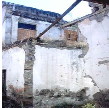
o Desplome de una escalera.
