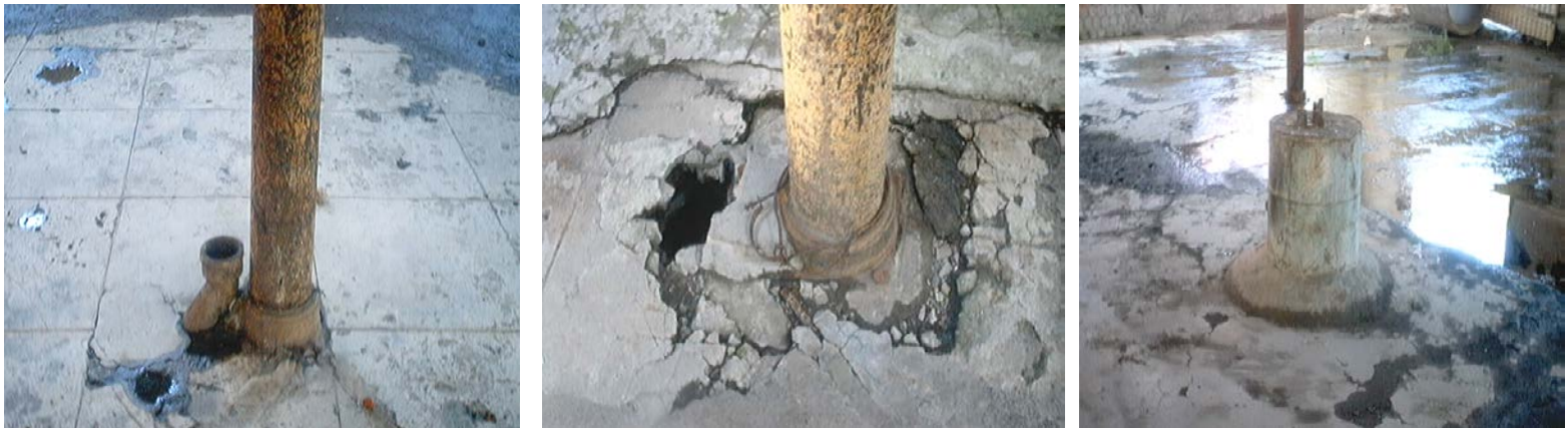
Abajo. ESTADO DE LAS BASES Y FUSTES DE LAS COLUMNAS METÁLICAS, DESPLANTES, INSTALACIÓN DE CAPTACIÓN PLUVIAL, PAVIMENTOS Y ACCESORIOS PRESERVADOS DE LA FÁBRICA.
