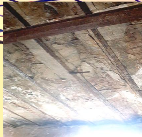
ESTADO DE LAS BÓVEDAS DE TABIQUE, TIPO CATALÁN EN SUS MATERIALES CONSTRUCTIVOS Y RECUBRIMIENTOS.
