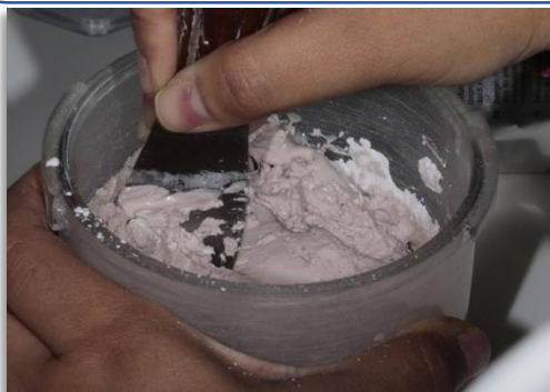
Fig. 177. Mezcla de revestimiento manual
