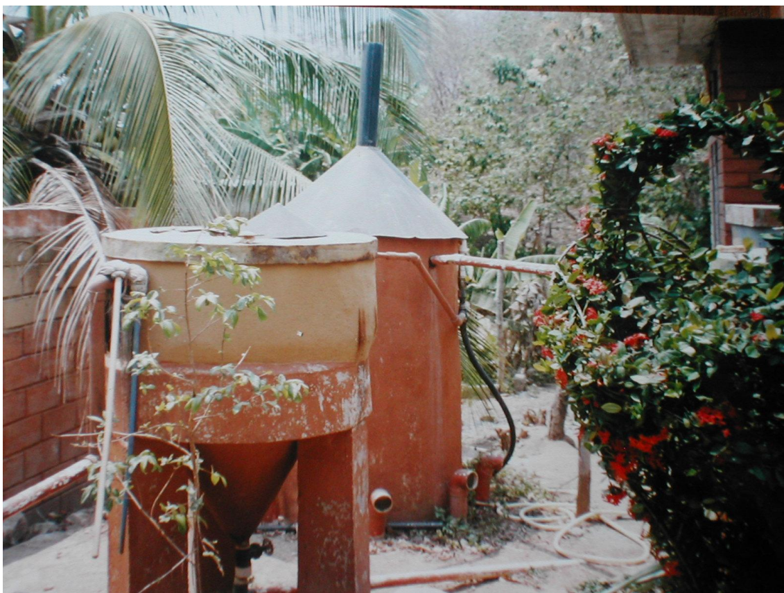
FOTO 11. Pequeña planta de tratamiento de agua que posee la fábrica de cremas de Mazunte.
