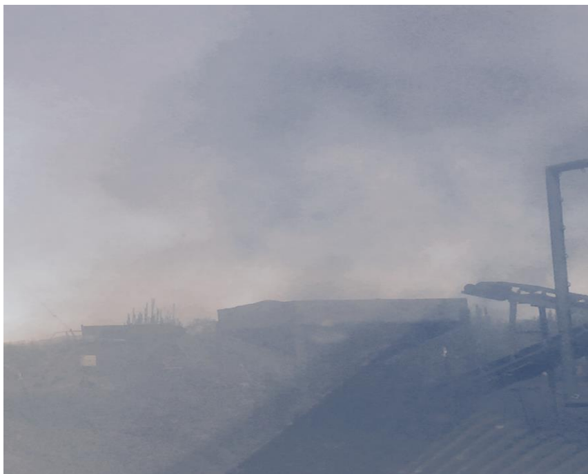
Figura 5.- Planta de beneficio de carbón mineral en operación.
