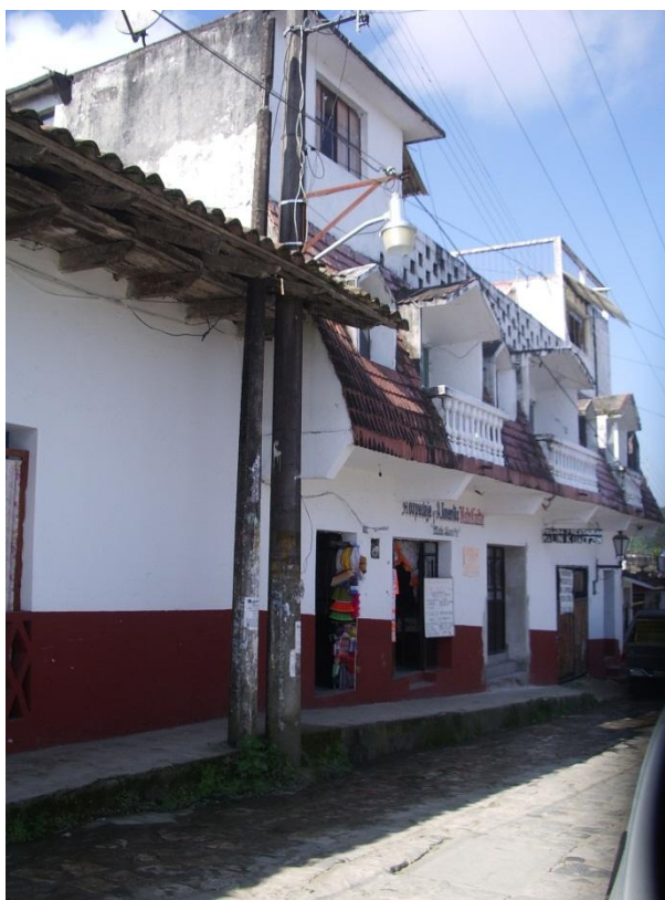
Construcciones de uso mixto dentro de la Zona Típica Monumental. Construcción nueva a lado de una vivienda tradicional. Postes y cableado aéreo que contaminan la imagen. (F.A.)
