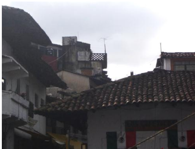
Vista de los añadidos sobre las cubiertas de teja (F.A.)
