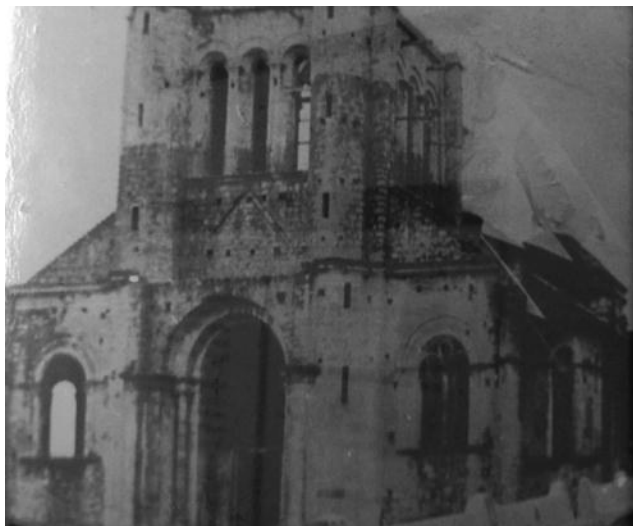
Templo de San Francisco en construcción. Fotografía del museo del Cuetzalan.
