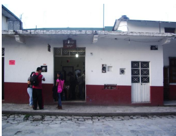
Viviendas del centro que no se integran al conjunto y alteran la vista desde el atrio. (F.A.)
