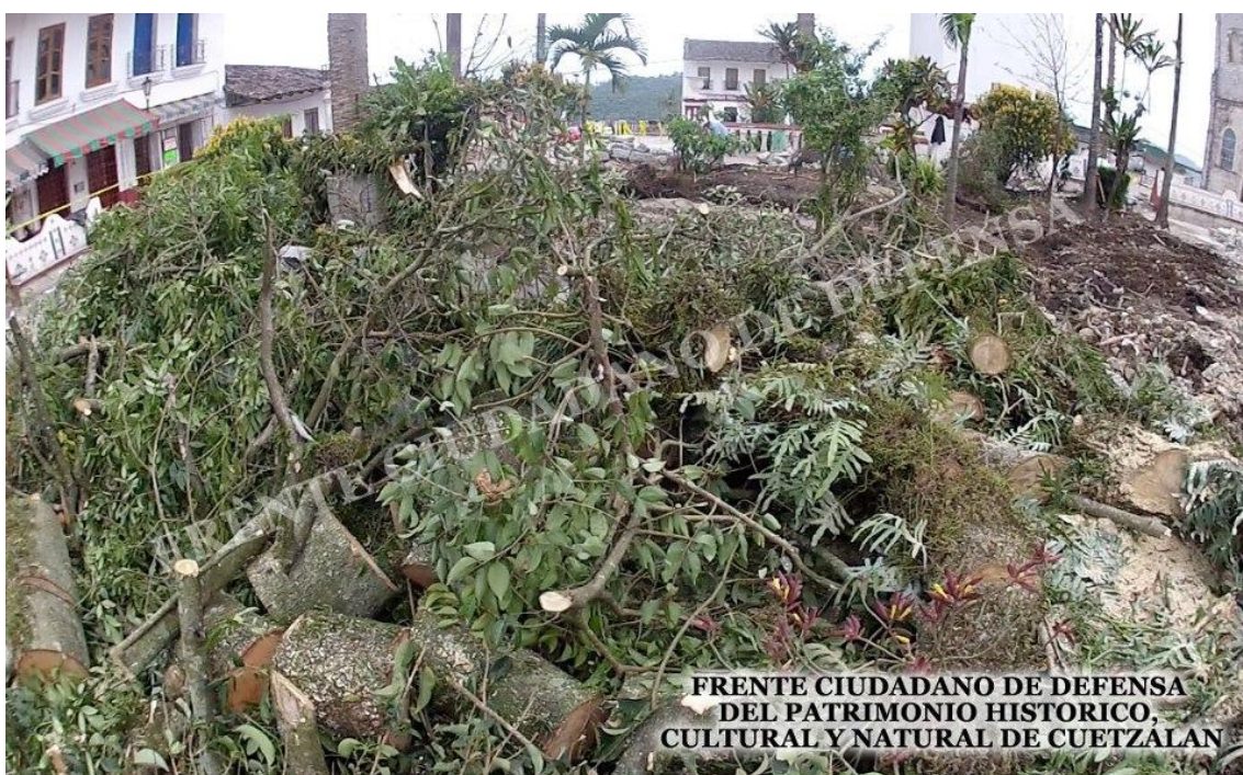
Desmantelamiento del parque. Fotografía del F.C.D.C.
