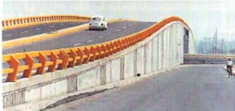
2.13 Imagen Vista Paso Superior Vehicular Avenida 16 de Septiembre cruce con Periférico Ecológico (1995)
