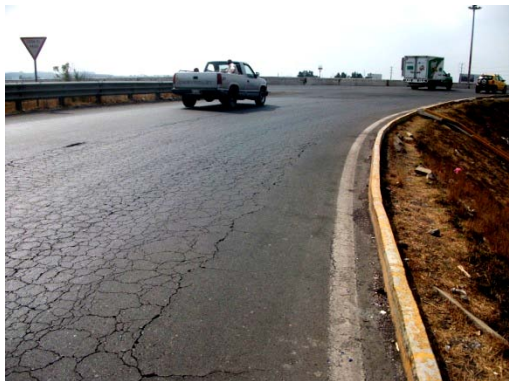
2.44 al 2.47 Imágenes del Periférico Ecológico con deterioros.
