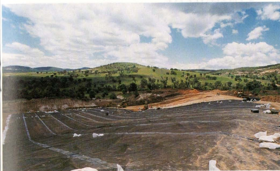
Aplicación de una geomembrana en la segunda celda del relleno sanitario.
