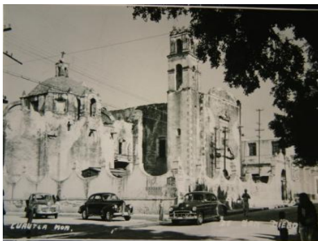
IMAGEN 14. IGLESIA Y EX CONVENTO DE SAN DIEGO. S.XX CENTRO HISTÓRICO DE CUAUTLA, MORELOS.
