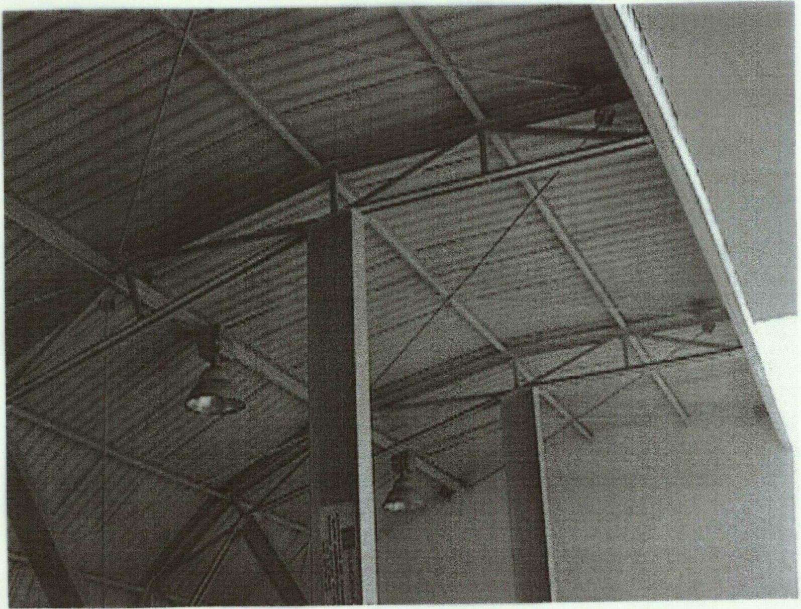
Estructura, ITR y cubierta de acero
