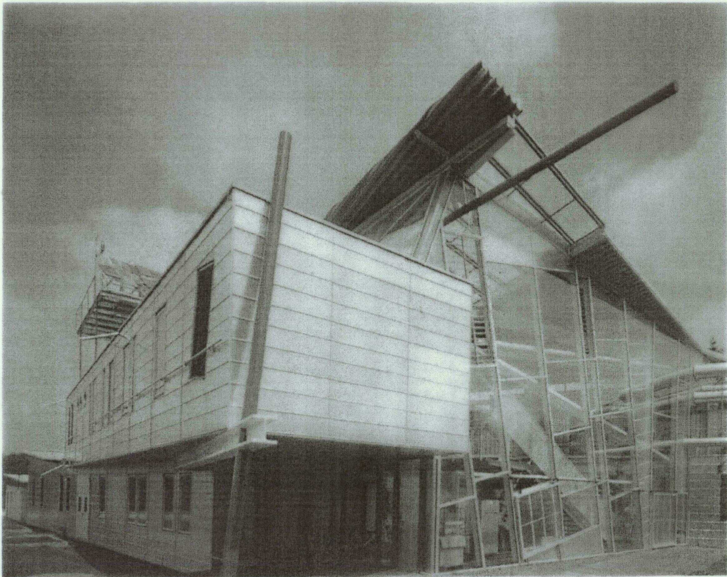
Edificio de investigación Hysolar de la Universidad de Stuttgart por Behnisch 1987
