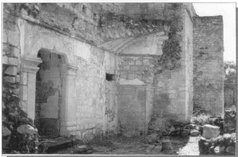
Espacio en ruinas adosado al refectorio
