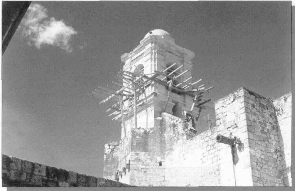
Apuntalamientos en la torre del convento
