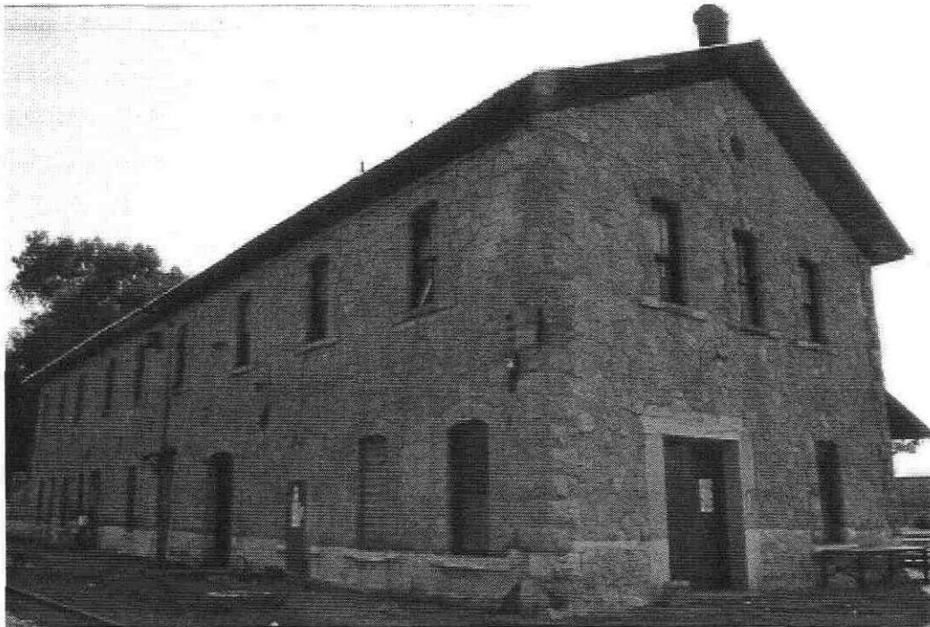
FACHADA PONIENTE Y FACHADA SUR
