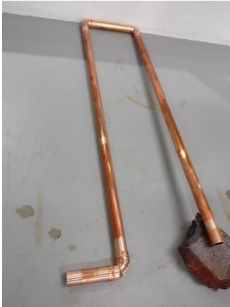
Figura 49. Unión de tubería
