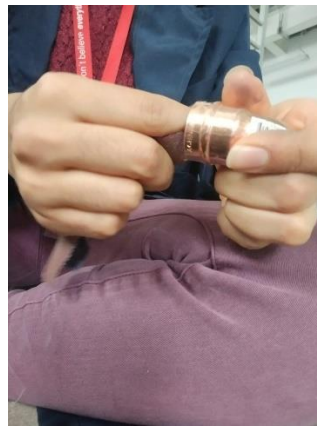
Figura 47. Lijado de codos para ensamble y soldado de las piezas
