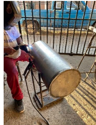
Figura 54. Soldado de tanque de almacenamiento de agua
