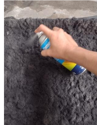
Figura 45. Capa de pintura sobre la superficie de la caja
