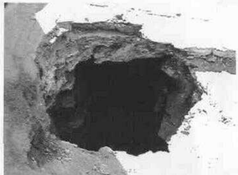
Liberación de relleno para trabajar en grieta.
