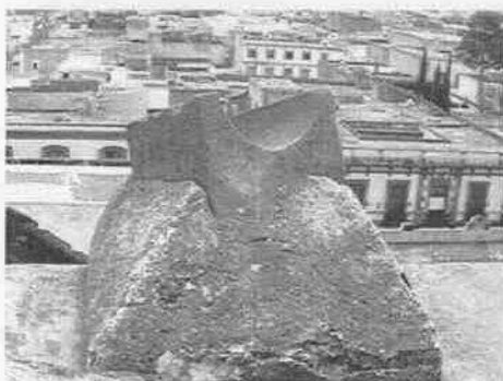
Reloj de sol sobre el pretil sur-oriente de la nave.
