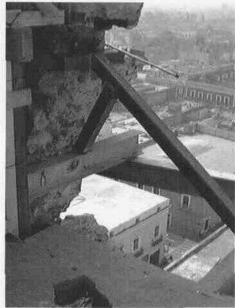
Trabajos de aseguramiento.
