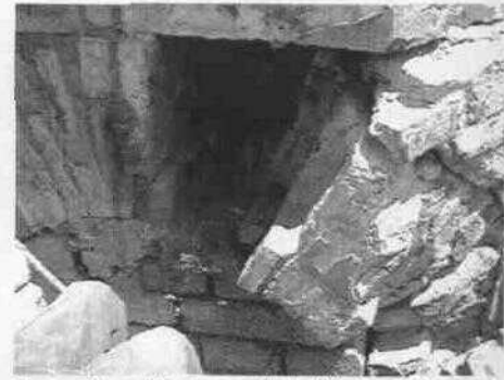
Reconstrucción de arco de ladrillo.
