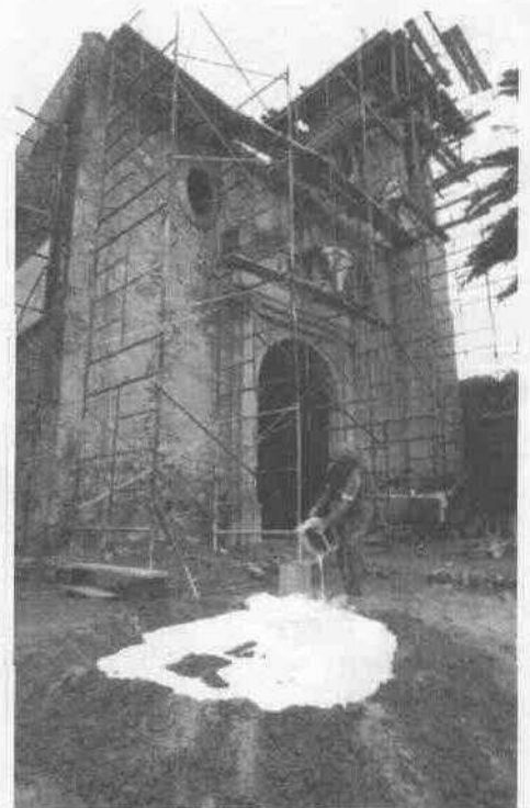
Uso de morteros expansivos en consolidación de muros. (Templo de San Jeronimito).
