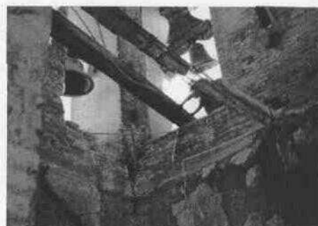
Cadenas de concreto en el primer cuerpo de la Torre.
