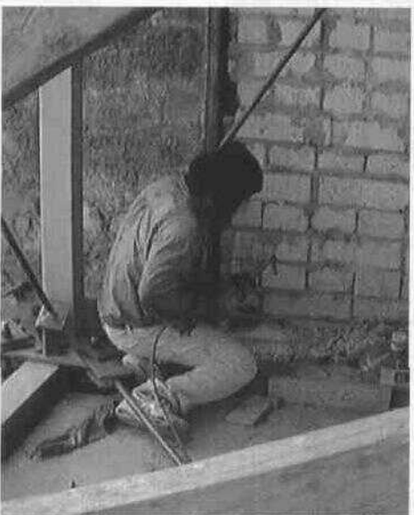
Colocación de tensores.
