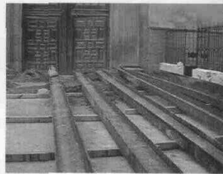
Vigas de acero antes de ser colocadas.
