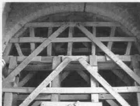
Apuntalamiento de arco en el deambulatorio.
