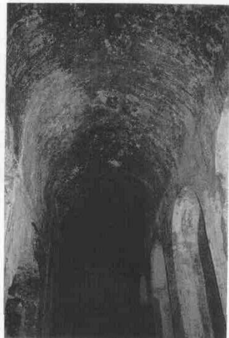
Grietas inyectadas con cemento-arena y SIKA Intraplast-Z.
