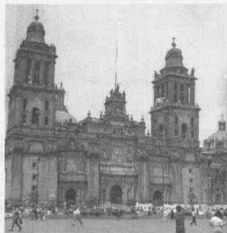
Proyecto de rectificación geométrica mediante la subexcavación.
