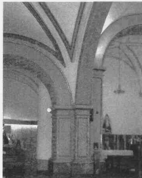
Pilastras de piedra de travertino y arcos fajones de ladrillo.
