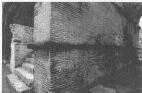
Aplicación de grapas metálicas de una antigua restauración.
