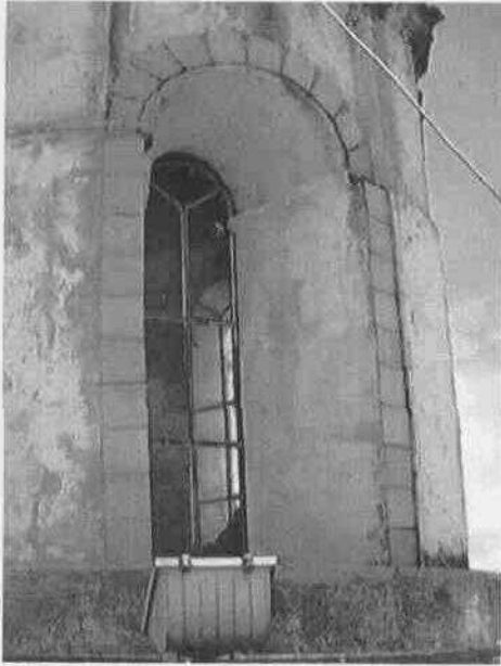
Azulejo de color amarillo en vano de cúpula.
