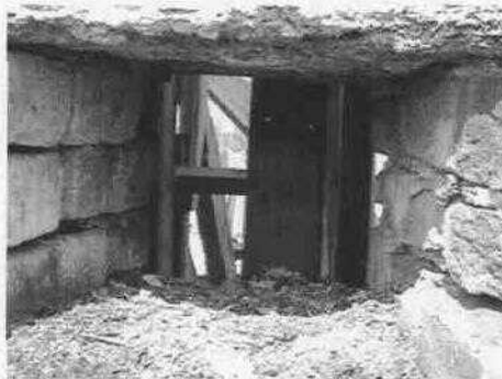
Vista del Apuntalamientos provisional.
