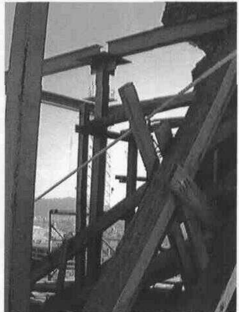
Aseguramiento para estabilizar la estructura y trabajar sin riesgo.
