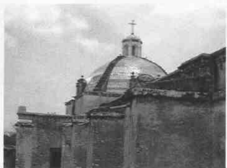
Muros mixtos de piedra de Cantera gris, travertino y ladrillo.
