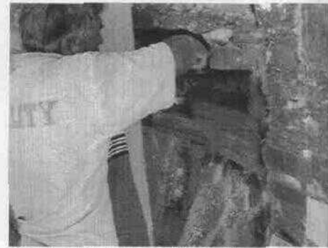
Trabajos de rejunteo para inyección
