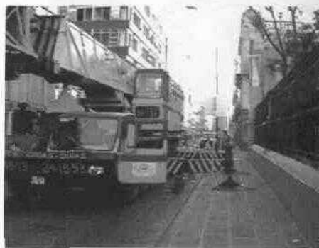
Equipo para el acenso de las vigas.
