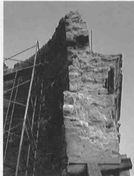
Muro mixto de la Torre con piedra de cantera y ladrillo.
