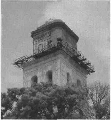
Integración de la parte faltante.
