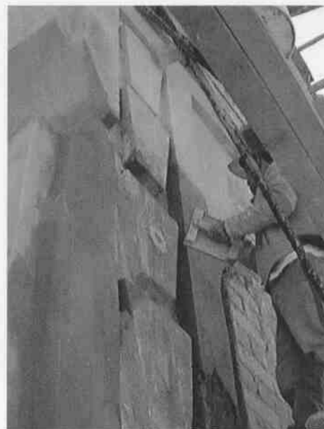
Trabajo de reintegración ubicando el elemento arquitectónico en su sitio.
