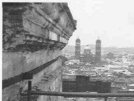
Vista del Zuncho metálico en la parte superior del segundo cuerpo.
