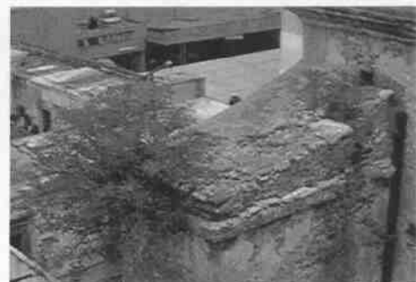
Limpieza de gárgolas y eliminación de parásitos vegetales.
