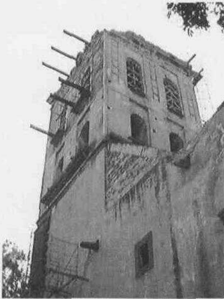
Apuntalamientos en el último cuerpo de la torre.
