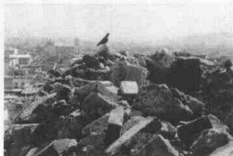
Trabajos de liberación como eliminar escombros producto del colapso.
