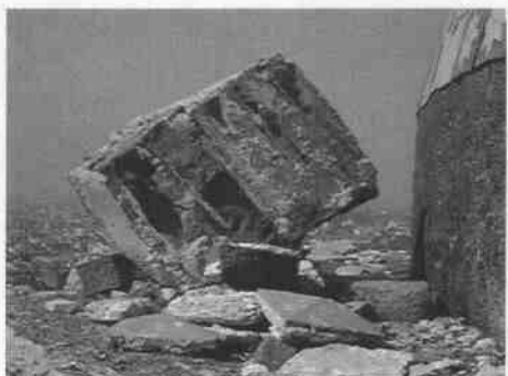
Material producto del colapso de la cúpula.
