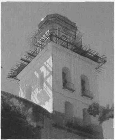
Trabajos de pintura el primero y segundo cuerpo de la torre.
