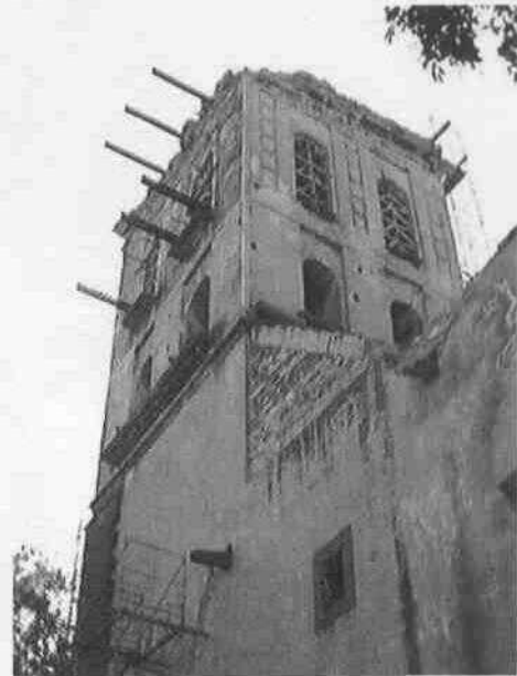
Vigas de acero "I" que sobre salen para colocar andamios provisionales garantizando la seguridad de los operarios.
