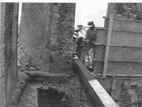
Colocación de viga de acero en el último cuerpo de la torre.
