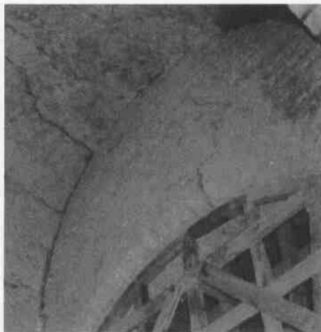
Detalle de apuntalamiento del arco.
