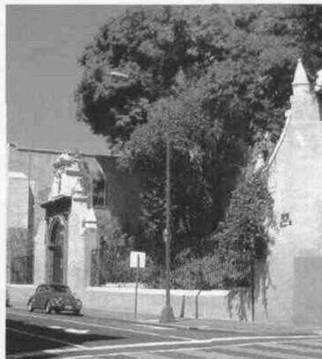
Barda Atrial con murete de piedra travertino y reja.
