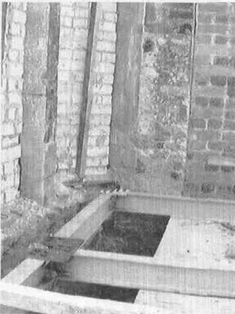
Vigas de acero y placas para recibir estructura provisional.
