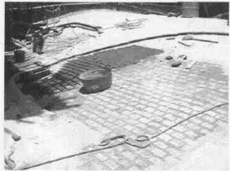
Restitución de Bóveda.
