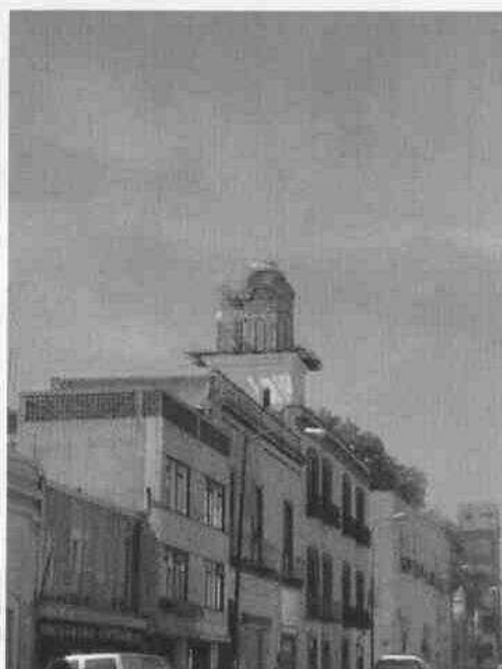
Cimbra provisional de block sin retirar.
