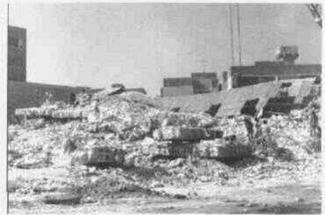
Daños por el sismo de 1985 en la Ciudad de México.
