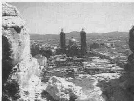
Uso de ladrillo asentado con mezcla de cal-arena en la fábrica de la Cúpula del Templo de San Agustín.
