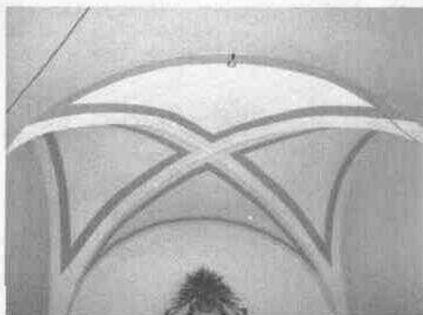
Bóveda de arista de una Capilla.
