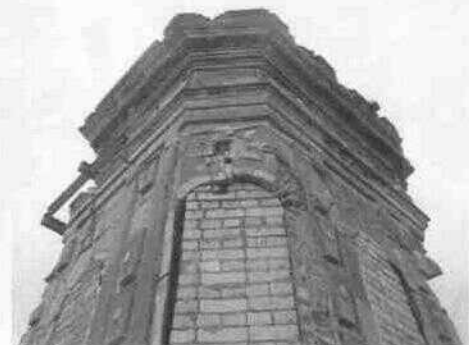
Cimbra de block y mortero simple con junta de polietileno para ser retirada al término de la reestructuración.
