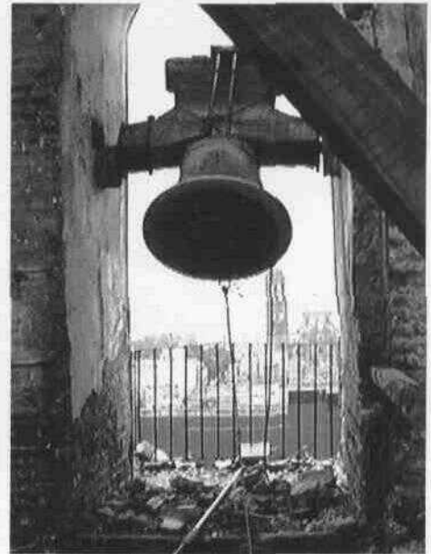
Vano de medio punto de la Torre trabajado en ladrillo.
