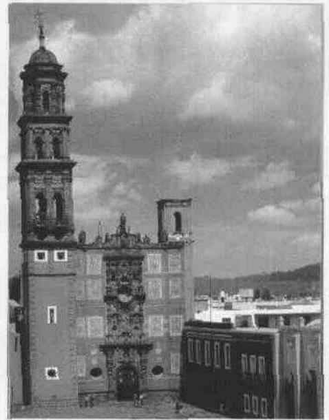
Vista del Convento de San Francisco.
