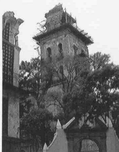
Suspensión de los trabajos en la Torre.
