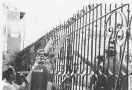
Deformación de la reja por el impacto.
