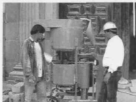
Máquina de inyección.
