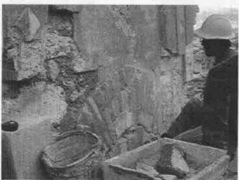
Trabajos de rejunteo para inyección
