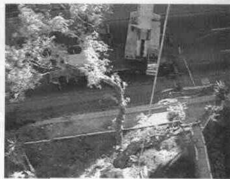
Pluma para colocar las vigas de acero.
