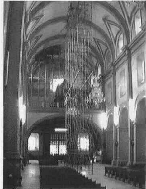
Andamios para intervención emergente y trabajo de consolidación.
