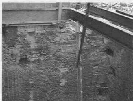
Desmontaje de riel en el último cuerpo de la torre.
