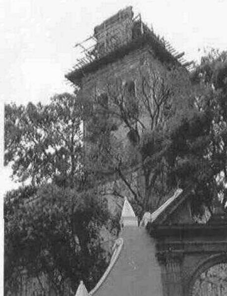
Detalle de los trabajos suspendidos en la Torre.
