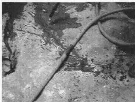
Inyección en Bóveda de la Capilla.
