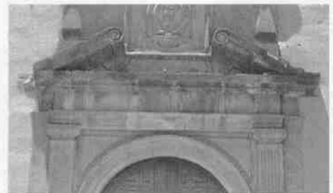
Restitución de piezas de Cantera.
