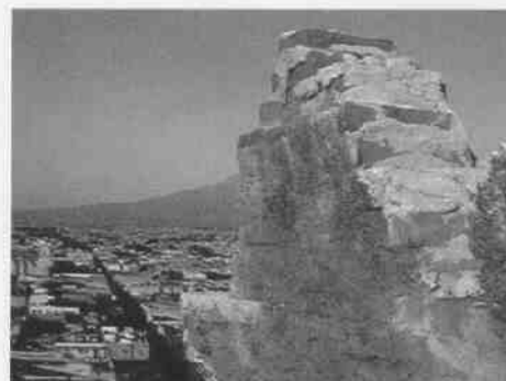
Vestigios del relleno que se utilizó como cimbra para reconstruir la cúpula de la Torre.
