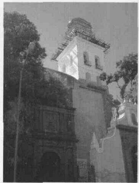
Trabajos de pintura en la Torre.
