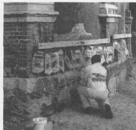
Aplicación del Sistema Drykitsistem.
