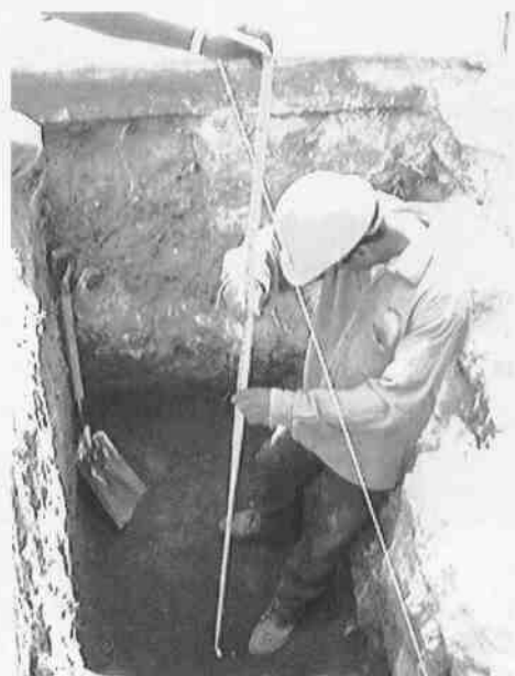
Excavación para determinar el tipo de cimentación.
