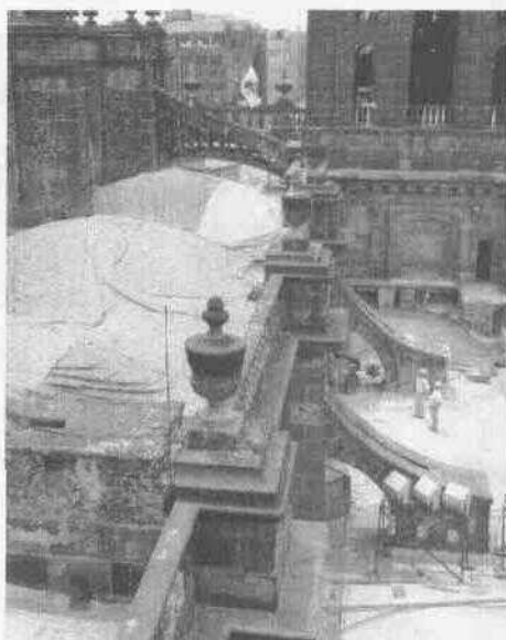
Punto de referencia para realizar los trabajos de subexcavación.
