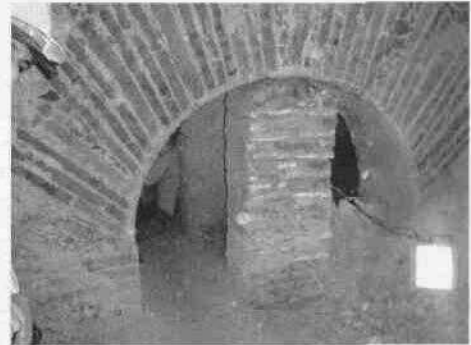
Vista del Túnel bajo el Altar.
