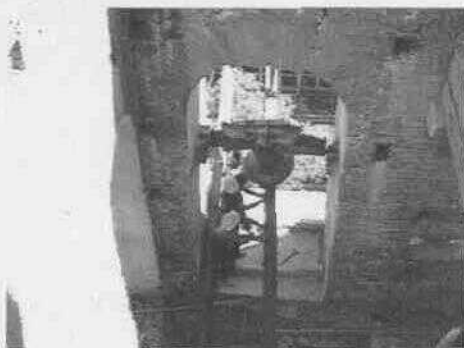
Colocación de vigas de acero.
