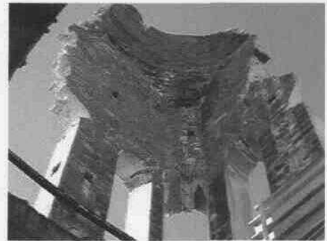
Ultimo cuerpo aún sin apuntalar debido a que se encontraba a 38.20 metros de altura.
