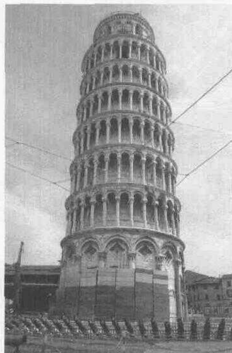
Vista general de la torre con los pesos de plomo y tubos para la sotoexcavación.
