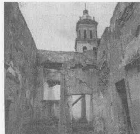
Destrucción del Convento de San Agustín.
