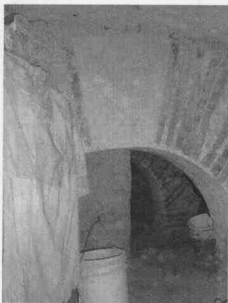
Acceso al túnel bajo el altar.
