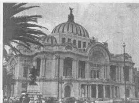
Fenómeno de hundimiento regional desde su construcción.
