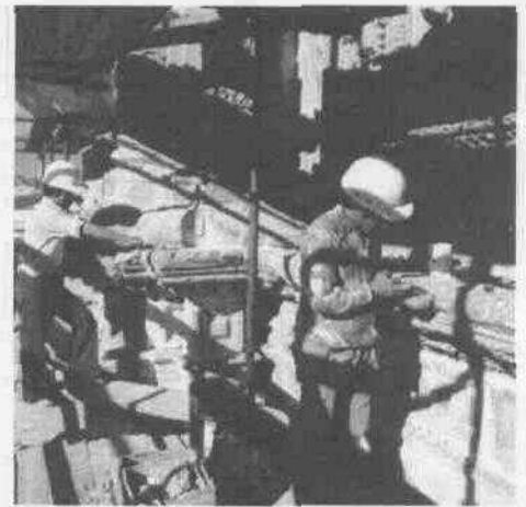
Consolidación a base de inyección de pegamentos epóxicos y morteros con aditivos expansivos. (Catedral de Oaxaca).
