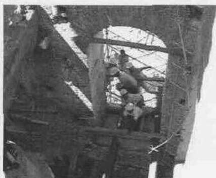
Trabajos de apuntalamiento.
