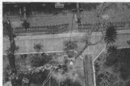
Vista de la barda atrial y reja que sufrió el impacto.
