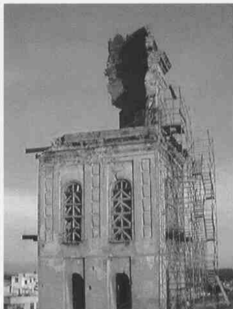
Trabajos preliminares de aseguramiento.
