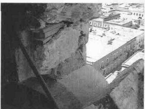
Cimbra del arco.
