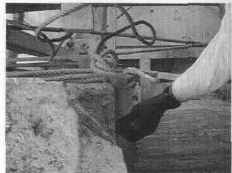
Trabajos para colocación de tensores.
