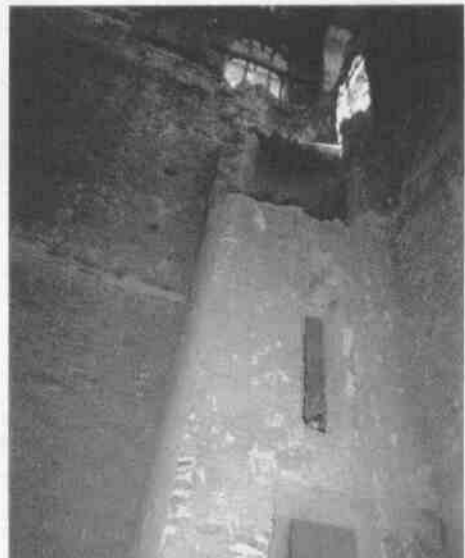
Muro mixto de cantera gris, piedra de travertino y ladrillo en cubo de escalera de caracol.
