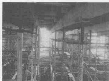
Uso de gato hidráulico para nivelar bóveda. (Templo de San Jerónimo).
