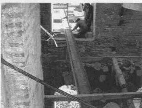
Colocación de viga de acero.
