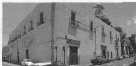
Estado actual del Convento de San Agustín.
