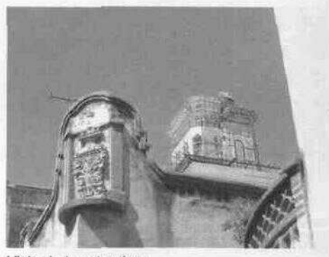
Vista de la estructura.
