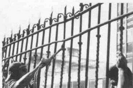
Trabajos de enderezado de la reja In Situ.
