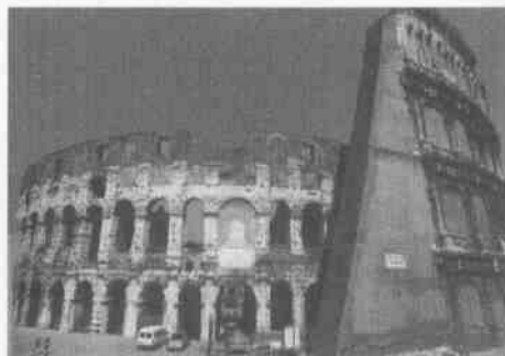
Contrafuerte en la zona oriente intervención de Stern en 1806-1807.
