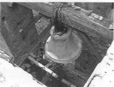
Trabajos de limpieza para apuntalamiento.
