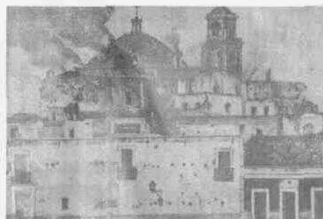
Daños al Templo por el movimiento armado.
