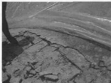
Bóveda de ladrillo de la nave del templo.
