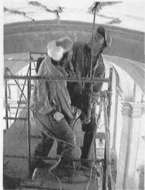
Preparación para inyección.
