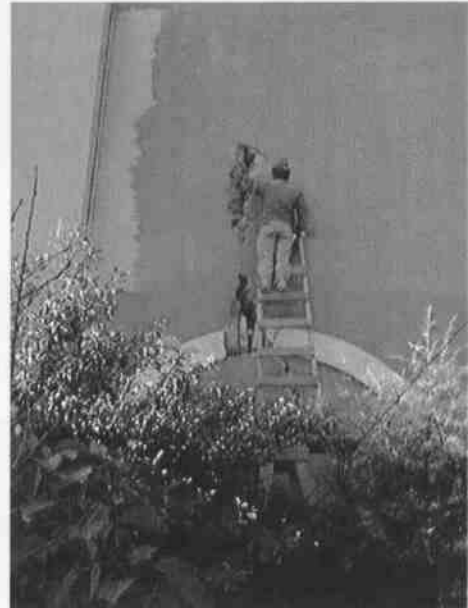
Inyección de grieta en muro.
