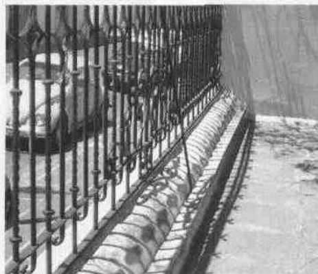
Restitución de aplanado en Barda Atrial.
