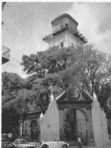
Trabajos de aplanado en el último cuerpo.
