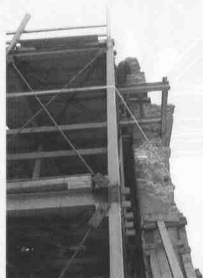
Trabajos de aseguramiento provisional mediante una estructura de acero en tres cuerpos, en el último cuerpo de la Torre.
