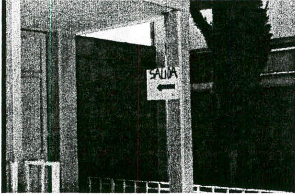
Problema: Señal improvisada de Salida.
