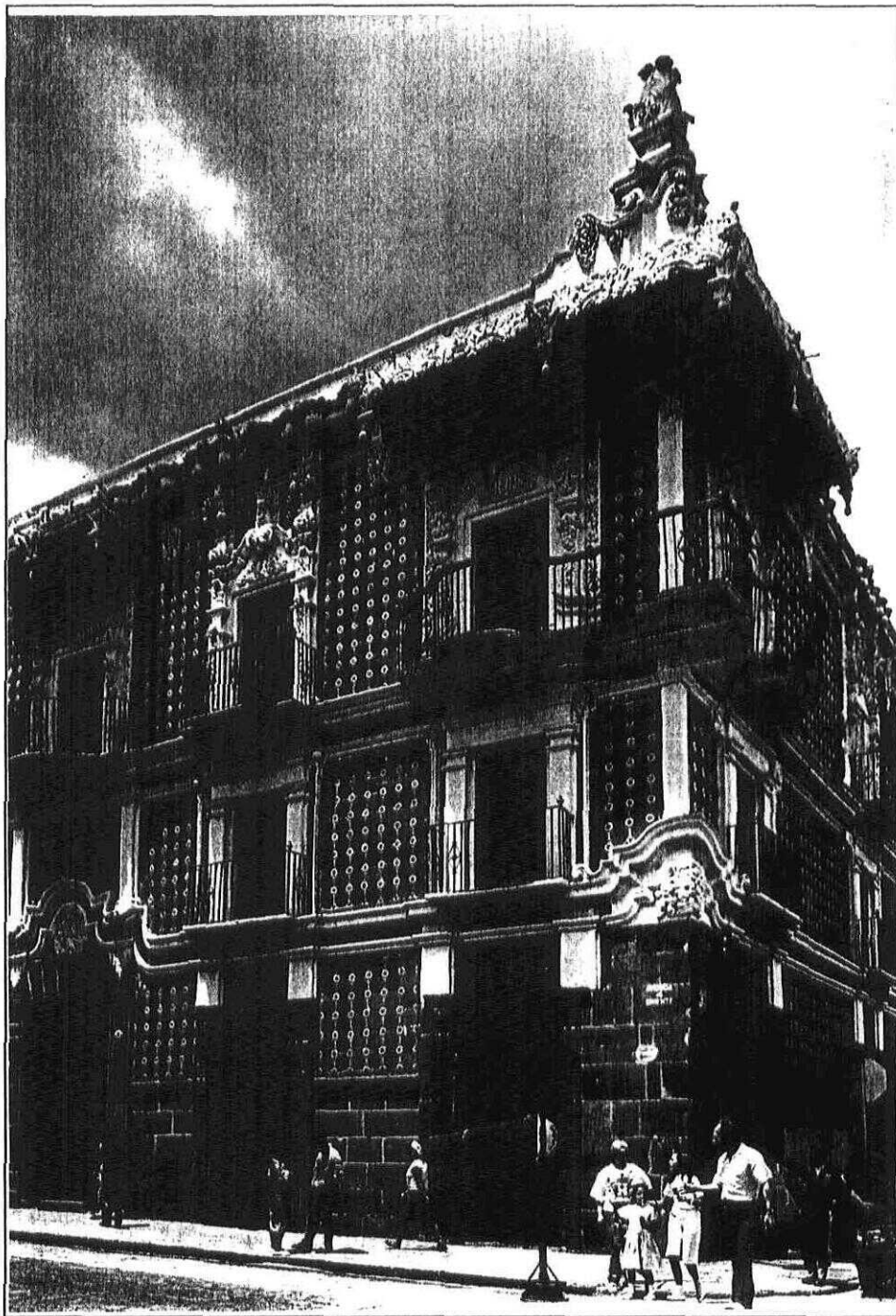
"CASA DEL ALFENIQUE" ESQUINA QUE PRESENTA UNA TORRECILLA HORNACINA.
