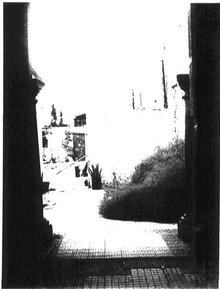
Enmarcamiento de cantería. Zaguán - Patio.
