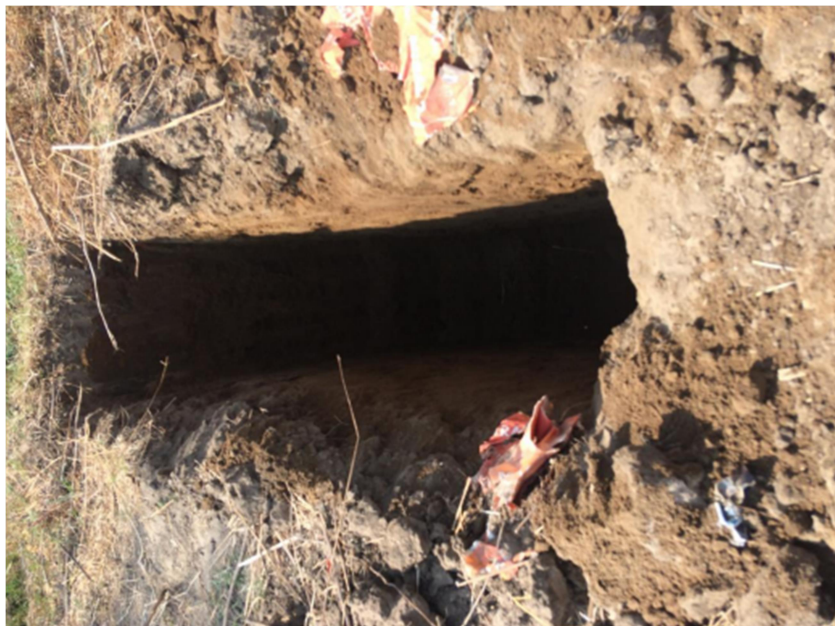
Ilustración 18. Pozo a cielo abierto, en predios donde se ubicaría el fraccionamiento San Pieri, fotografías realizadas por el despacho Proyectos Punto Exacto. En el año 2018.
