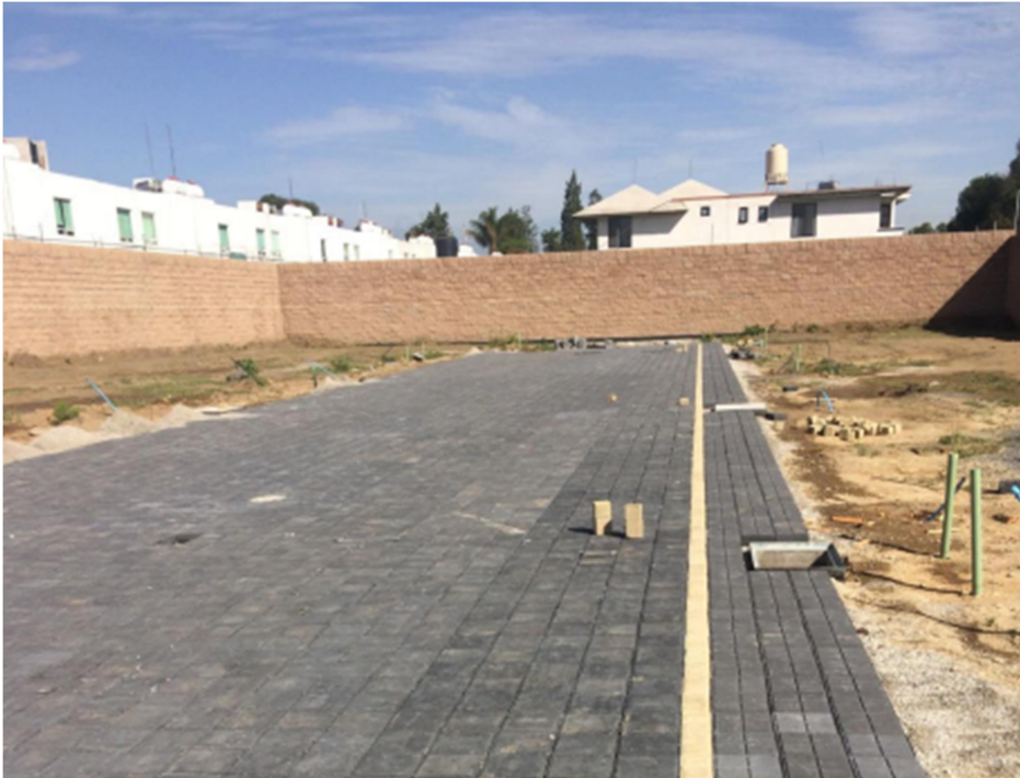
Ilustración 32. Fotografía tomada en sitio a inicios de obra de material de vialidades. Fotografía tomada por Proyectos Punto Exacto.
