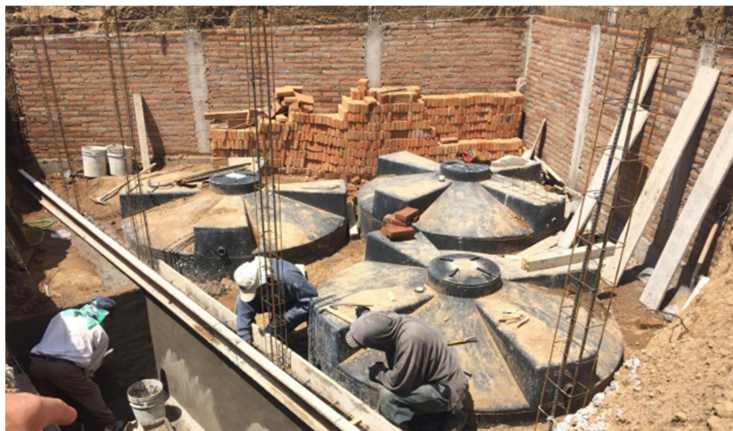
Ilustración 30. Fotografía tomada en sitio, biodigestores ubicados en acceso de fraccionamiento San Pieri, foto tomada por Proyectos Punto exacto.
