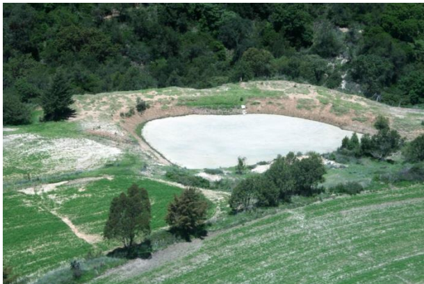
Figura15. Jagüey en el Estado de Tlaxcala, que funciona para sistemas de almacenamiento de agua, con diversos usos (Coordinación General de Información y Relaciones Públicas [CGIRP], 2015).
