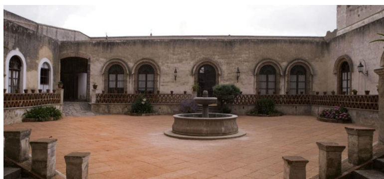
Figura 17. Viviendas de trabajadores de confianza que ejemplifica la estructura arquitectónica de las Haciendas (NRM Comunicaciones, 1998).
