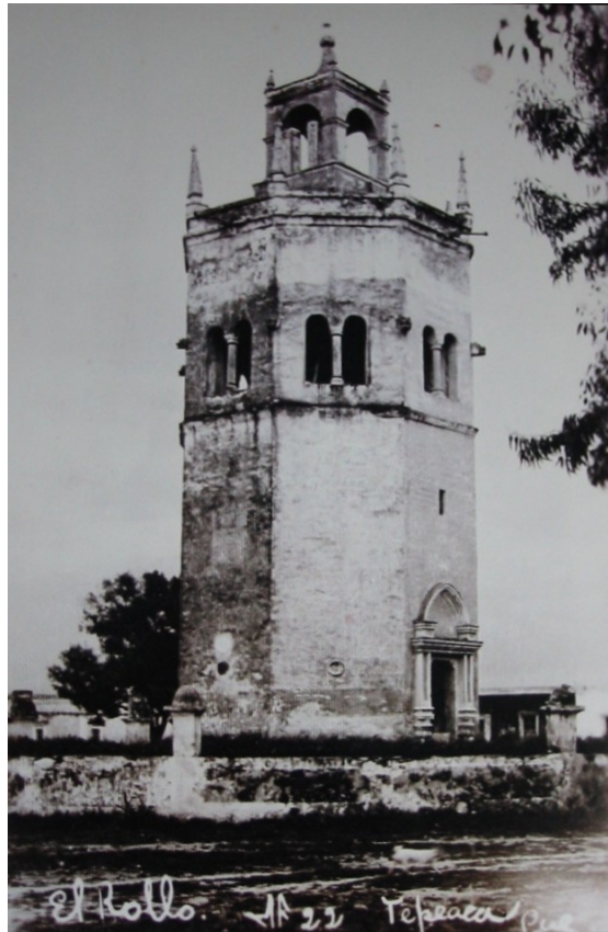
Fotografía histórica. El Rollo ubicado al poniente de la plaza en acabado de piedra, con aplanado deteriorado, los vanos de la linternilla están libres. En el zócalo no existen escalones, existen postes rodeando al rollo y se observa presencia de vegetación en el zócalo. Propietario: Ing. José Luis Contreras Coeto
