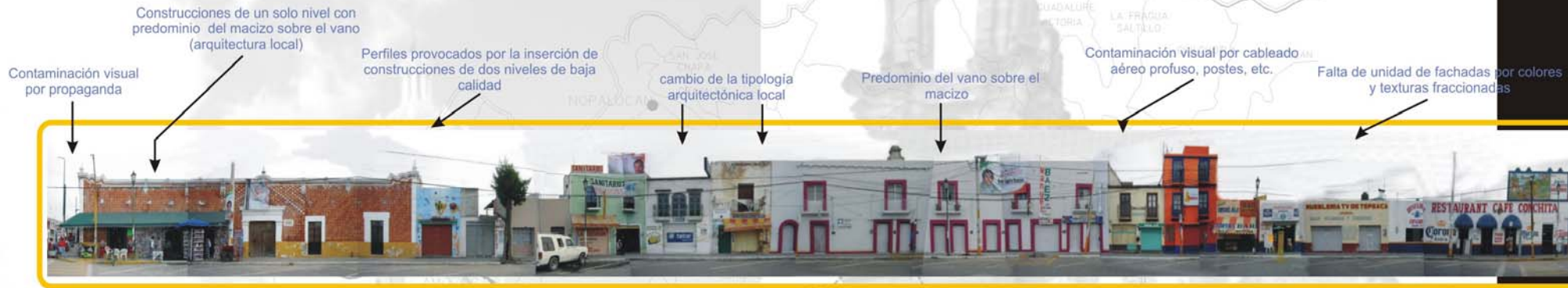
FACHADA NORTE DE LA PLAZA
