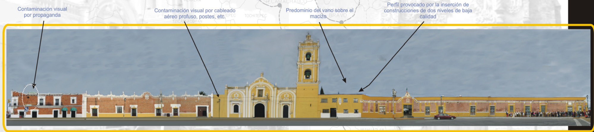
FACHADA PONIENTE DE LA PLAZA
