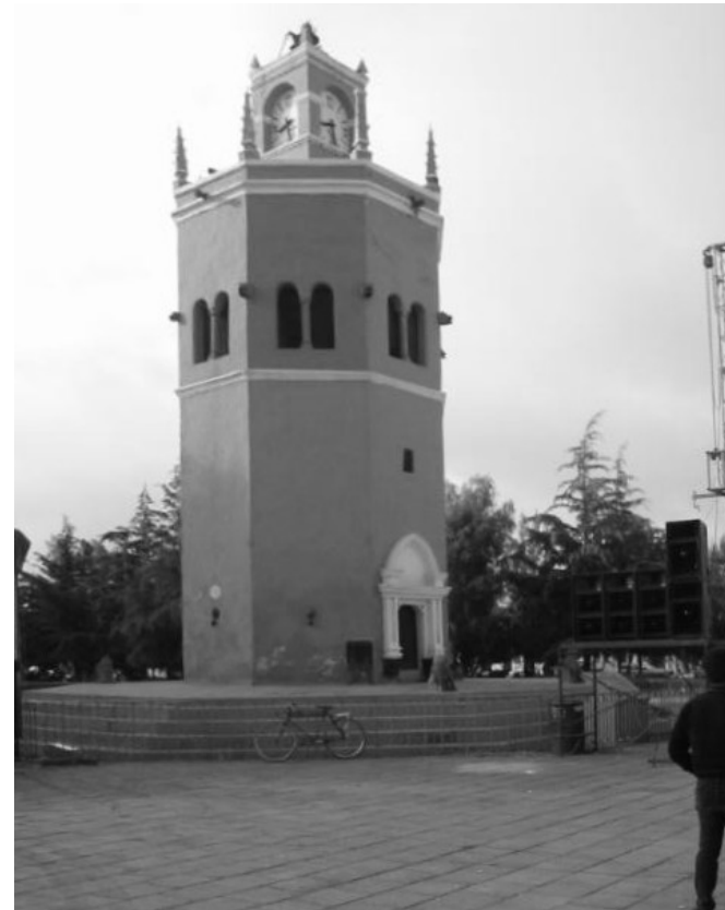
Fotografía actual (marzo de 2004). El Rollo en acabado de aplanado fino y pintura vinílica. Desaparecen los postes que rodeaban a este hito Colocación de escaleras para acceder a él. Se observa mayor existencia de vegetación. Colocación de reja para delimitar el área y el vano de la linternilla ocupado por un reloj.
