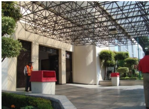
Figura 5. Contenedores para residuos sólidos en general
