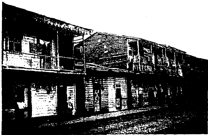
Area tugurizada en el Centro Histórico de Panamá. El antiguo "Marañón" de viviendas de madera de la mano de obra del Canal de Panamá constituye una tipología singular en la arquitectura americana.
